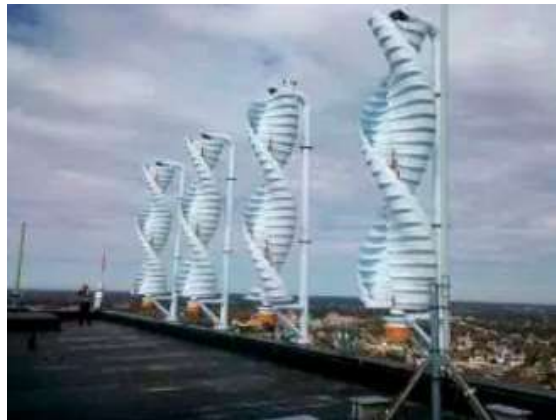
Figura 2.27 Aerogenerador tipo Savonius.
