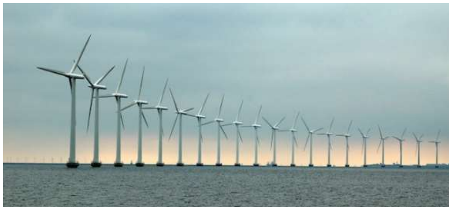
Figura 2.35 Aerogenerador orientado Barlovento.
