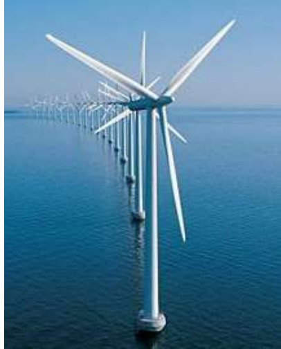
Figura 2.32 Aerogenerador tipo Tripala.
