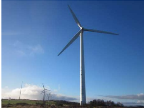
Figura 2.35 Aerogenerador orientado a Sotavento.
