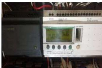
**Figura 55.- Módulo de Micro PLC Zelio para Máquina de Inyección.**
