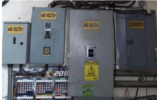
**Figura 46.- Interruptor principal de 3 por 400 Amperes, 440 Volts.**
