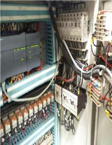
**Figura 15.- Tableros de control eléctrico para máquinas de inyección.**
