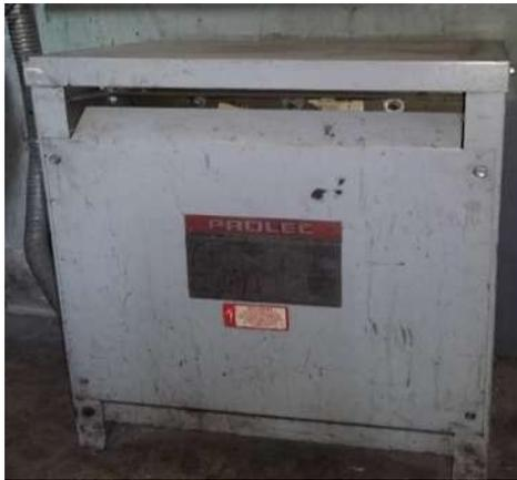
**Figura 48.- Unidad de Transformación Tipo Seco.45KVA, 440 V-220/127 Volts.**
