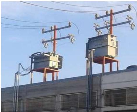
Figura 34.- Subestaciones de 300 KVA Y 225 KVA
