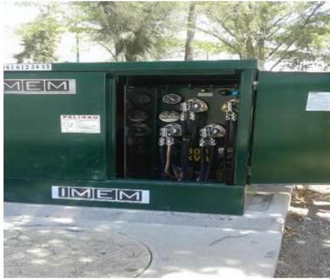
**Figura 10.- Transformador trifásico tipo pedestal.**
