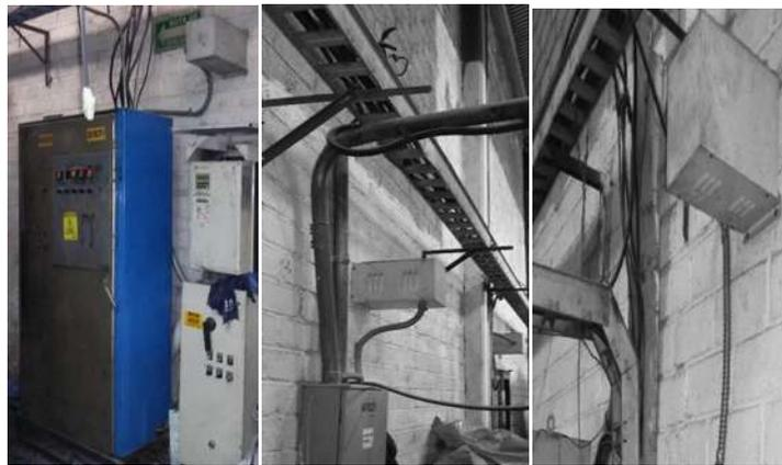
**Figura 49.- Bancos Automáticos de Capacitores.**
