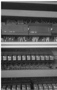
**Figura 26.- PLC Marca Siemens Step S7-7200.**
