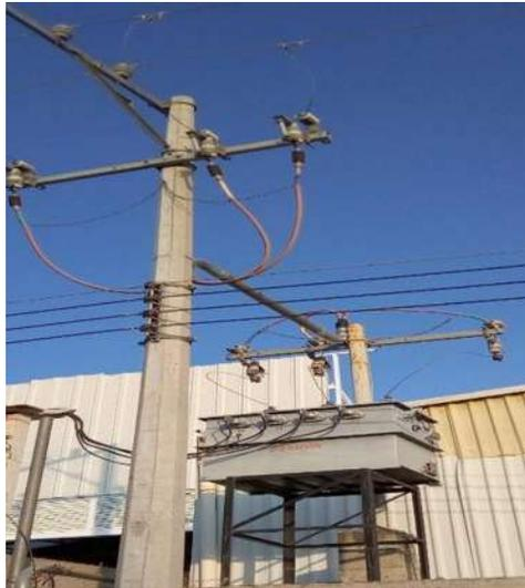
**Figura 44.- Transformador de 112.5 KVA de Capilla.**
