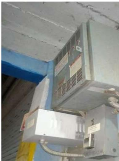
**Figura 41.- Instalación de Banco Fijo de Capacitores**
