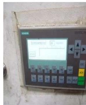
**Figura 30.- Panel de configuración para PLC STEP-1200.**
