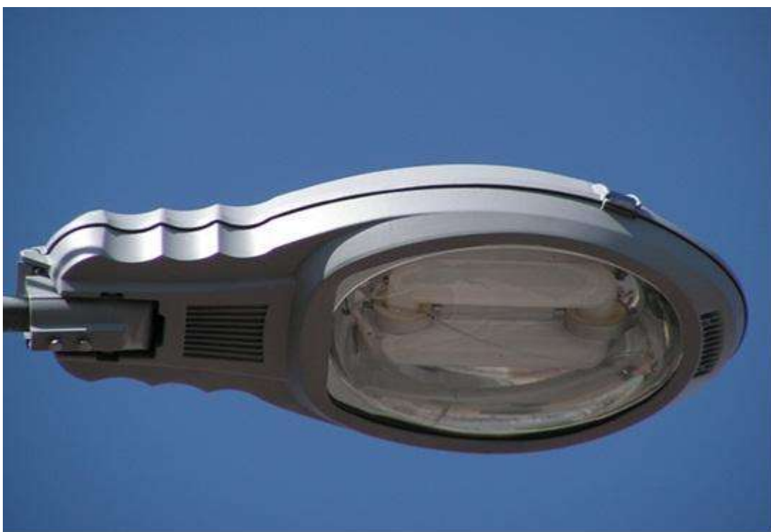
Figura 26.- Lámpara Vapor de Sodio de Alumbrado Público
