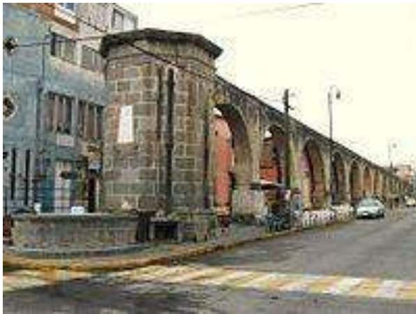
Figura 15.- Acueducto (esquina calle Hidalgo)
