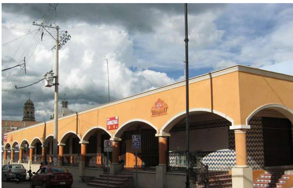
Figura 30.- Fachada mercado municipal de Acámbaro
