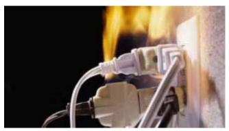
Figura 2-13 Sobrecarga eléctrica de un tomacorriente [14].
