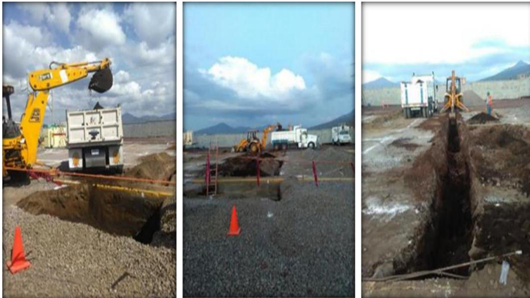
***Figura 5.5 Excavaciones de cimentaciones para sistema de tierras.***
