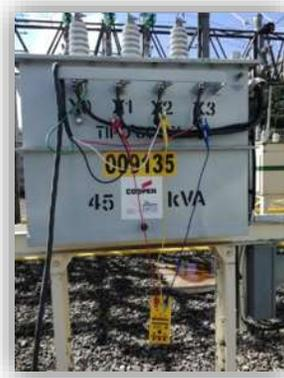
**Figura 4.35 Revisión de secuencia de fases en TSP Subestación Paracho Dos**
