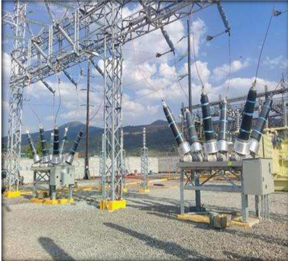
***Figura 5.11 Conexión de interruptores de tanque muerto***
