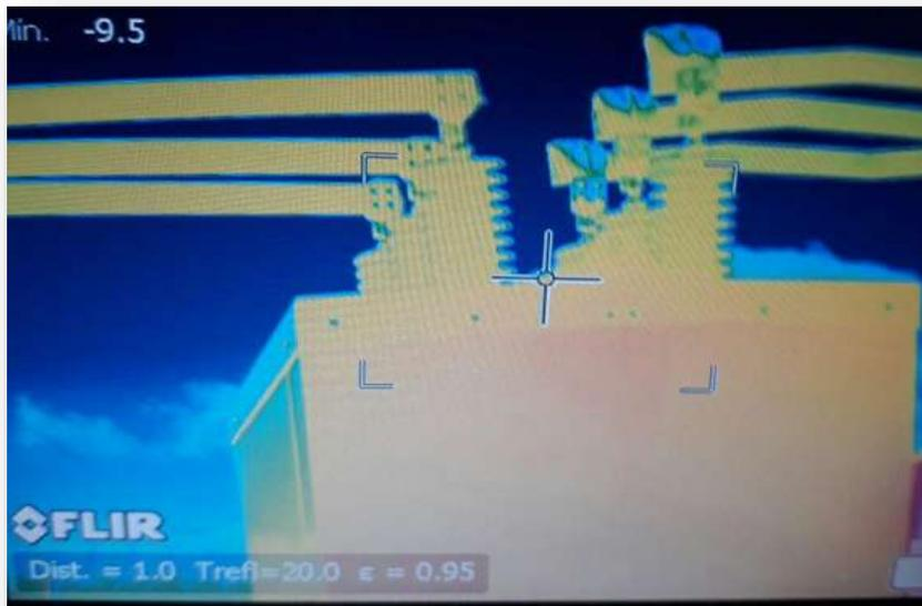
**Figura 4.49 Revisión termográfica en bus 13.8 kV**
