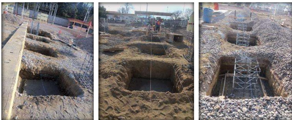
**Figura 5.7 Plantilla para bases de concreto para elementos primarios de bahía de 115 kV**
