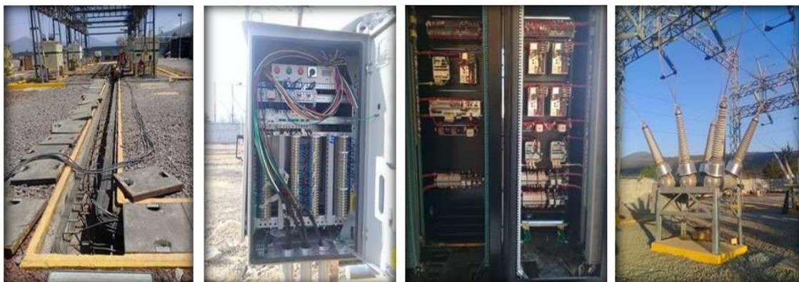
**Figura 5.14 Tendido de cable de control a tableros PCyM para pruebas de cierre y apertura en interruptores de tanque muertos.**
