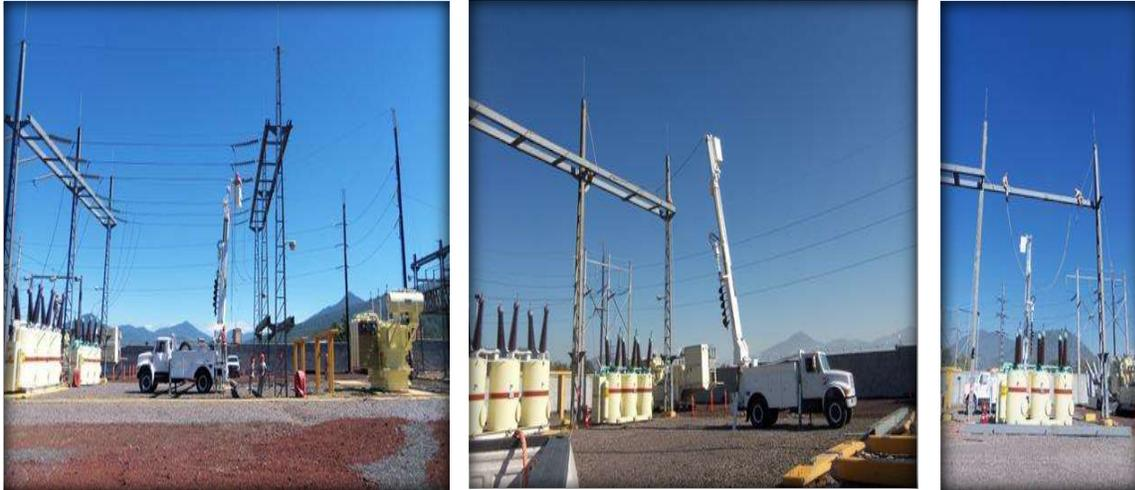
***Figura 5.4 Desmantelamiento de equipo primario, traveses y estructuras en bahía de 115 kV***
