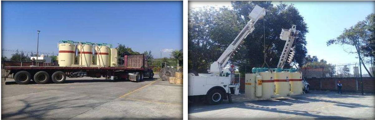
**Figura 5.13 Retiro de interruptores de aceite de la SE POD**
