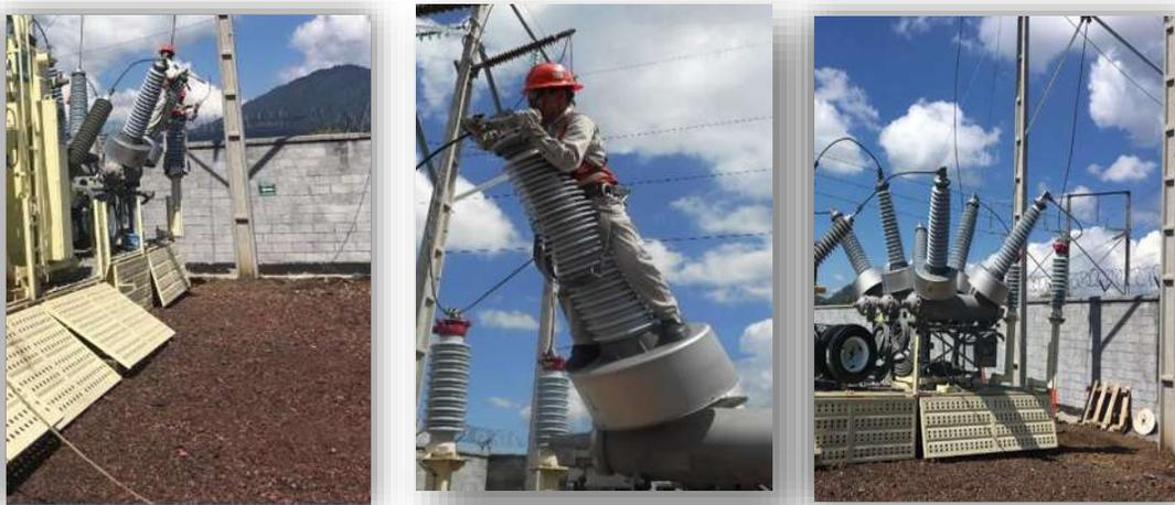
**Figura 4.29 Conexión de línea de 115 kV en interruptor de Subestación Móvil**
