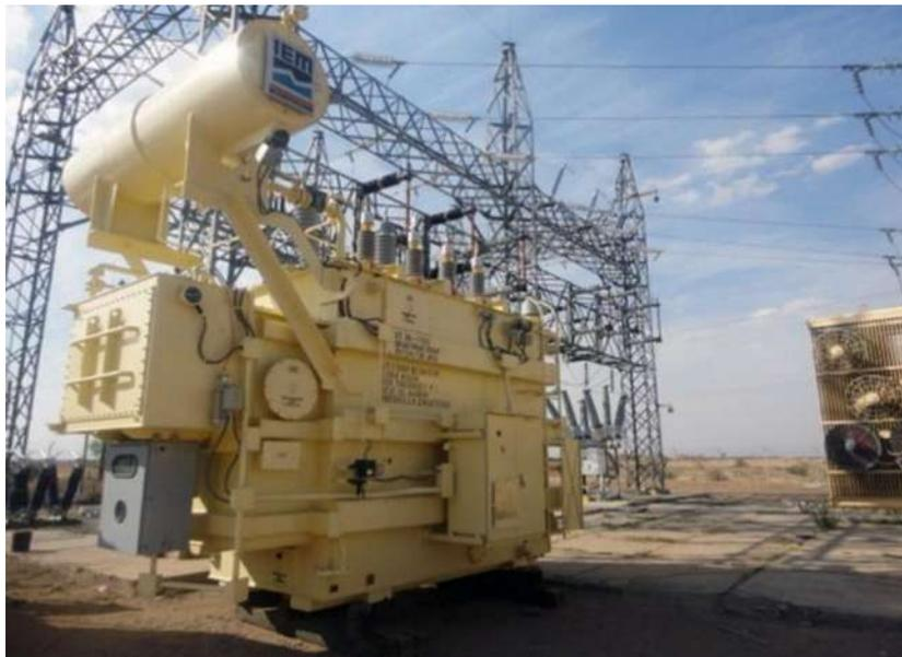
***Figura 2.7 Transformador de potencia***
