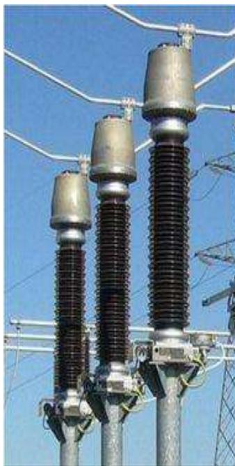
***Figura 2.16 Transformador de potencial***
