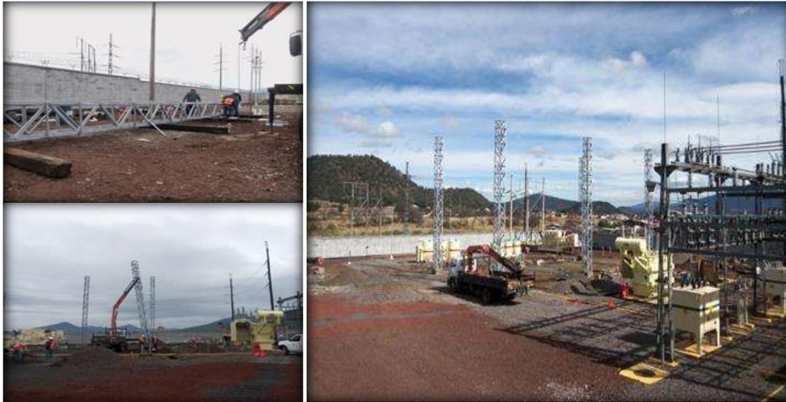
**Figura 5.8 Armado y montaje de estructura de bahía 115 kV**
