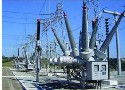
***Figura 2.14 Interruptores de potencia***
