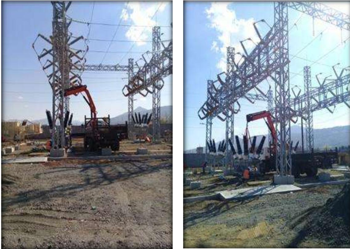
***Figura 5.10 Instalación de interruptores de tanque muerto***
