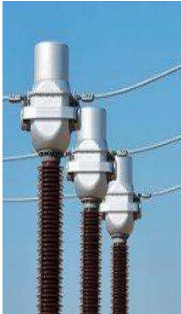
***Figura 2.17 Transformador de corriente***
