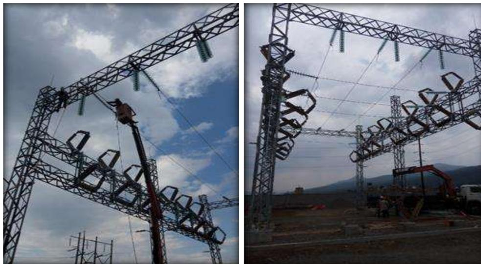
**Figura 10.9 Montaje de elementos primarios en bahía 115 kV**
