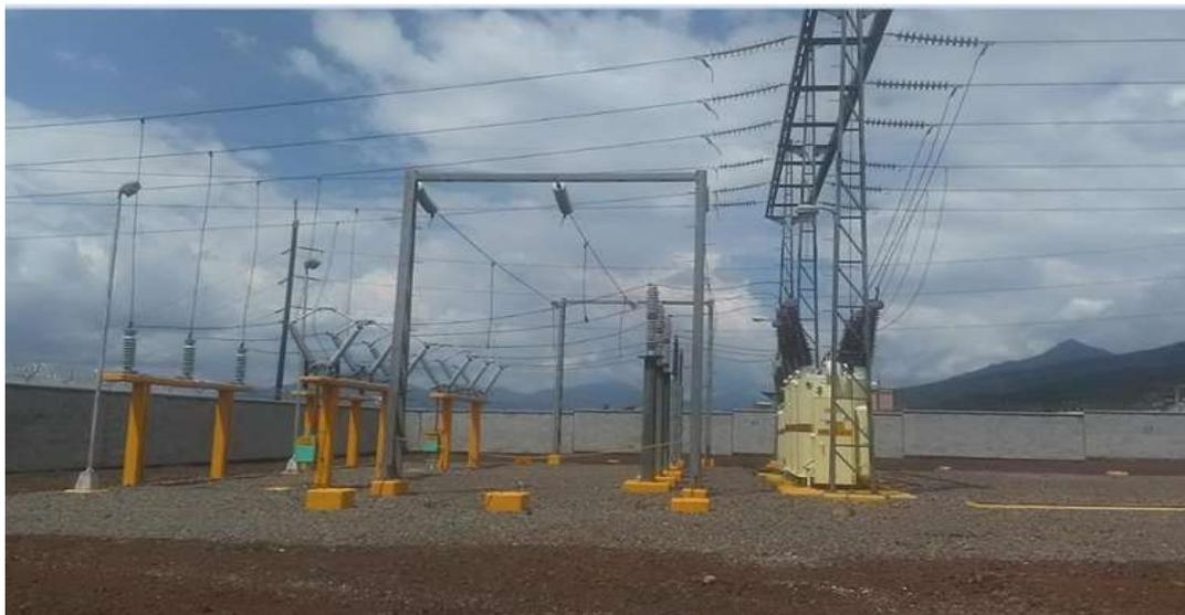
***Figura 5.2 Cuchillas motorizadas e interruptores de gran volumen de aceite***
