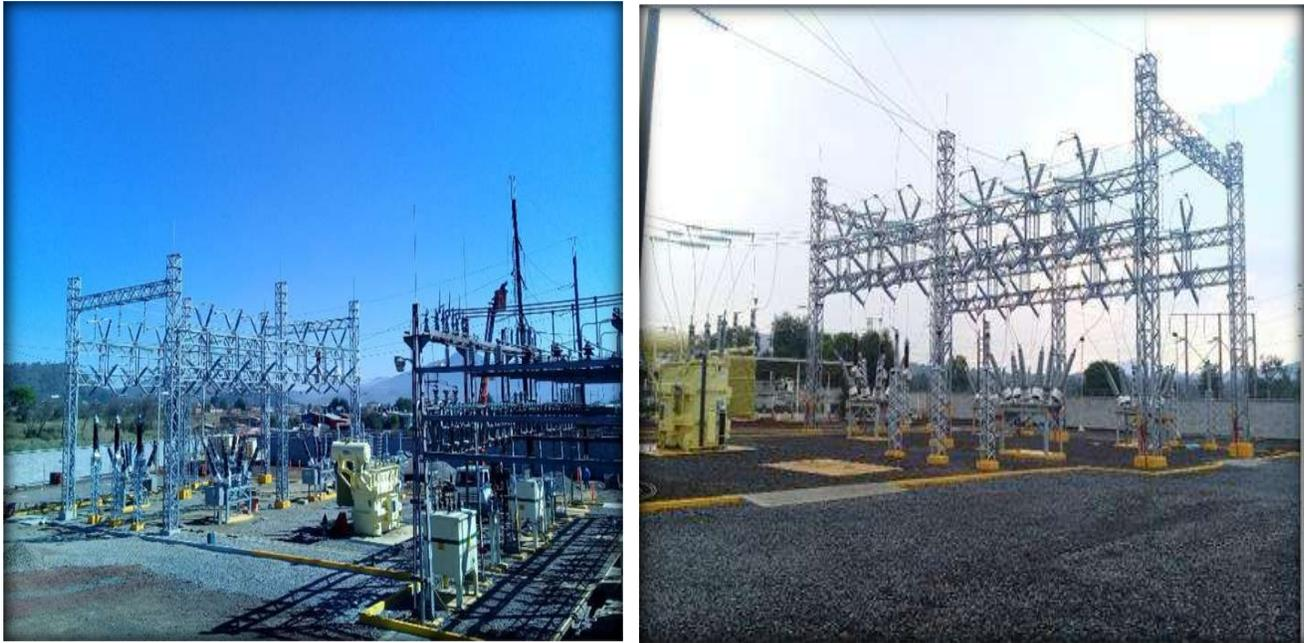
**Figura 5.16 Bahía de 115 kV de SE POD remodelada**
