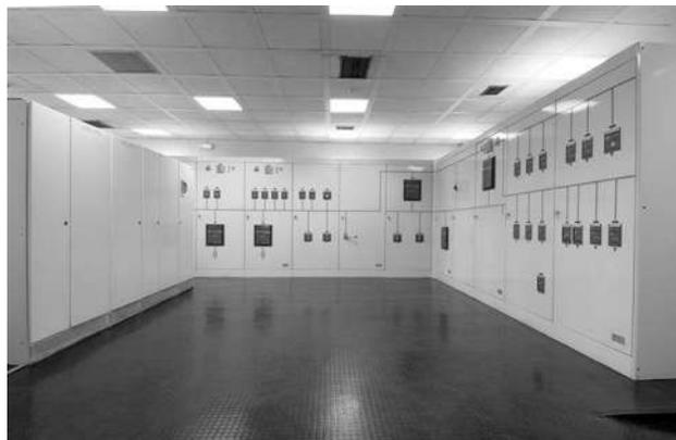
***Figura 2.4 Subestación Eléctrica tipo blindada***
