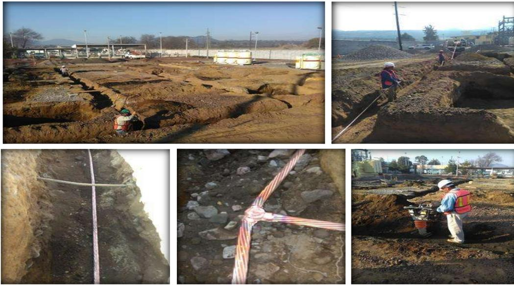
**Figura 5.6 Hincado de electrodos y tendido de cable de cobre desnudo CU para sistema de tierras**
