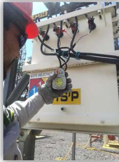
**Figura 4.42 Revisión de secuencia de fases en TSP de Subestación Charapan**
