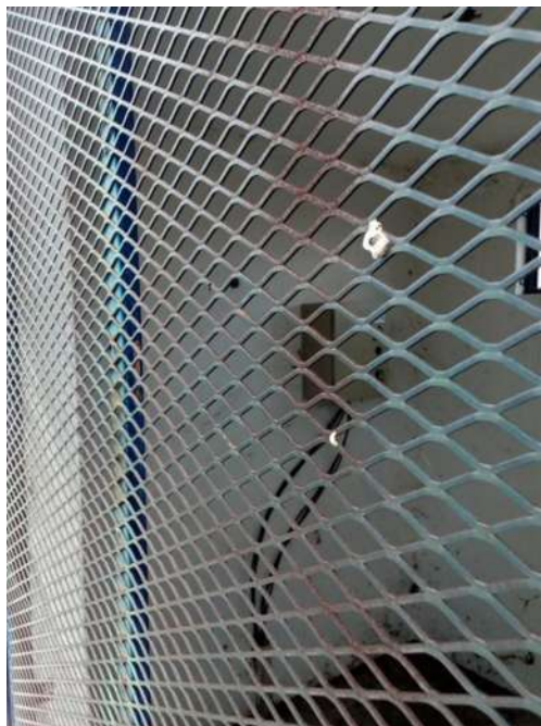
FIGURA 20.- CUARTO DE CONTROL EN EL POZO DE PATZIMARO DE AVIÑA.
