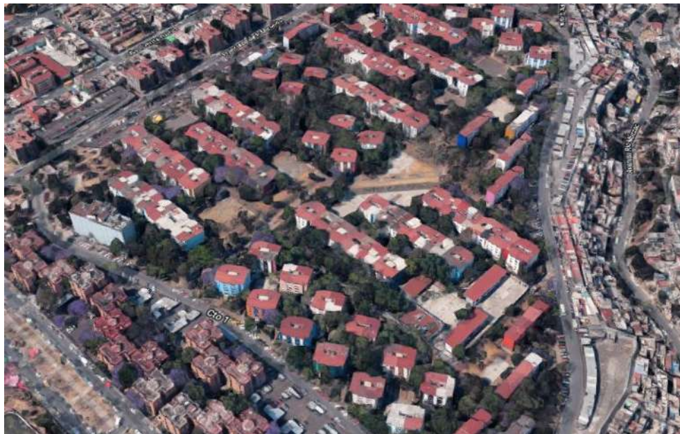
FIGURA 9.- CONJUNTO HABITACIONAL LOMA DE PLATEROS. IMAGEN TOMADA CON GOOGLE MAPS.
