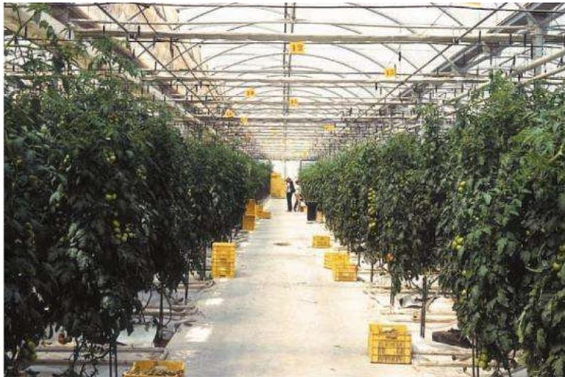
Fig. 1-9. Invernadero multitúnel de lámina plástica [12].
