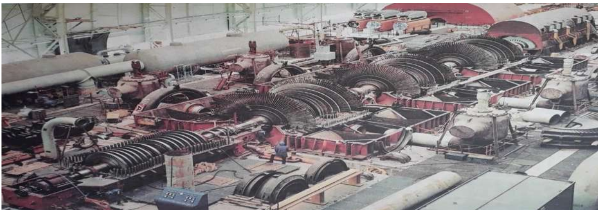
Figura 3.6 Turbina de vapor ALSTHOM en proceso de montaje. Una de las dos unidades de la planta nucleoelectrónica de FESSENHEIN (Francia). Potencia 1 000 MW; velocidad de giro: 1 500 rpm; longitud del eje: 59 metros. [19]
