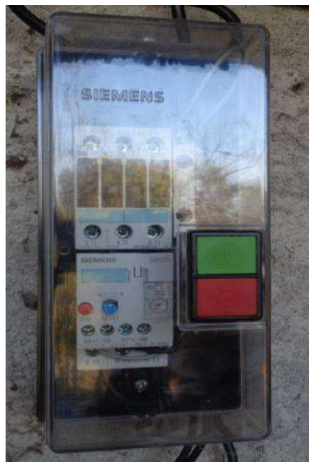
Figura 9. Arrancador de un motor trifásico.
