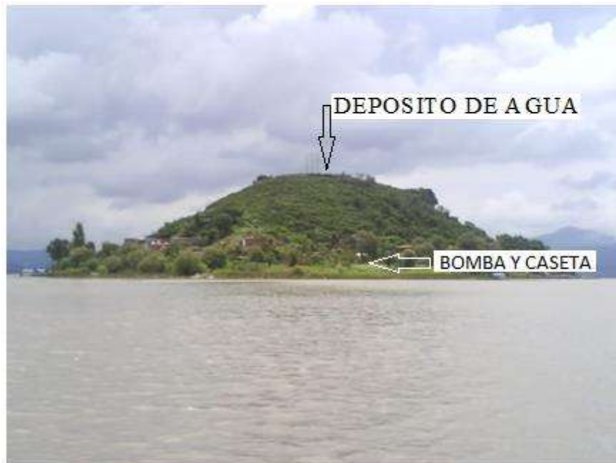
Figura 11. Ubicación del depósito y la caseta de control en la isla Tecuena
