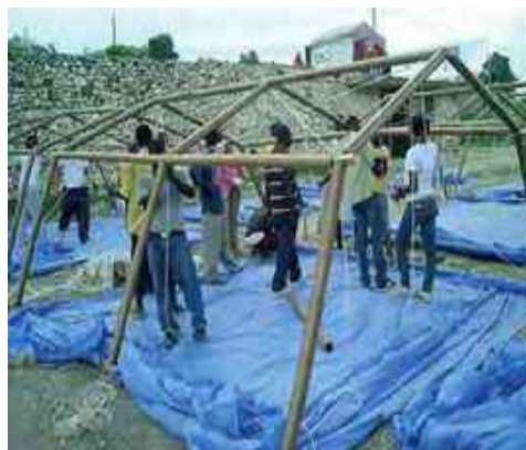
FIG. 67 Sistema constructivo de habitáculo a base de tubos de papel. Tomado de http://www.shigerubanarchitects.com/works/2015_nepal_earthquake-2/index.html
