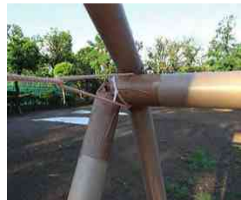
FIG. 67 Sistema constructivo de habitáculo a base de tubos de papel. Tomado de http://www.shigerubanarchitects.com/works/2015_nepal_earthquake-2/index.html
