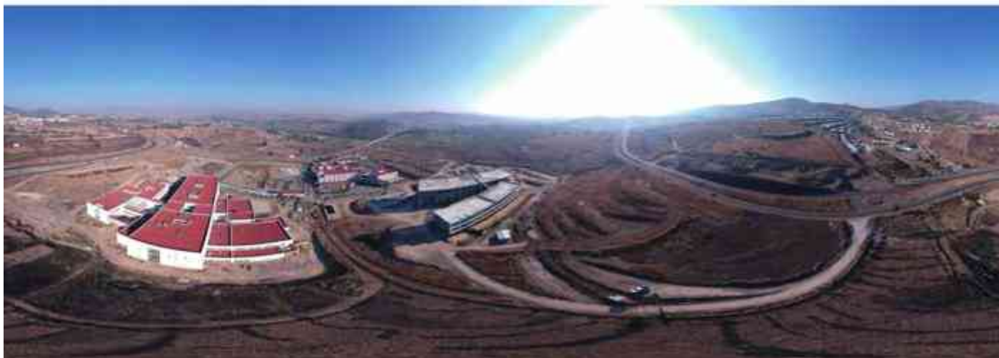
FIG. 64 Arriba: Vista de dron del estado de la construcción hasta diciembre 2018. Foto aérea por INVENTIA 2018.
