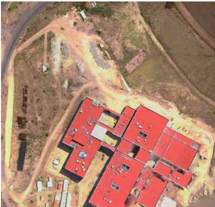
FIG. 06 Sitio del nuevo hospital infantil. El edificio existente es el hospital general. Marzo 2017.
