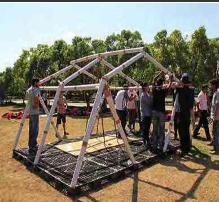
FIG. 68 Sistema constructivo de habitáculo a base de tubos de papel. Tomado de http://www.shigerubanarchitects.com/works/2015_nepal_earthquake-2/index.html
