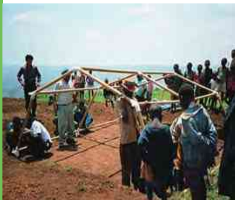
FIG. 67 Sistema constructivo de habitáculo a base de tubos de papel. Tomado de http://www.shigerubanarchitects.com/works/2015_nepal_earthquake-2/index.html
