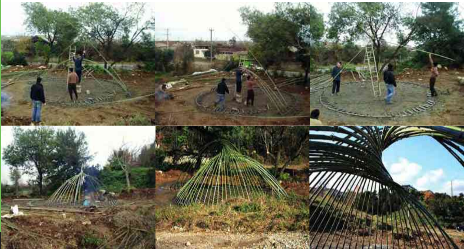
FIG. 76 Proceso constructivo del habitáculo “Bamboo Shelter”. Imágenes tomadas de https://www.archdaily.com/93922/bamboo-structure-project-pouya-khazaeli-parsa
