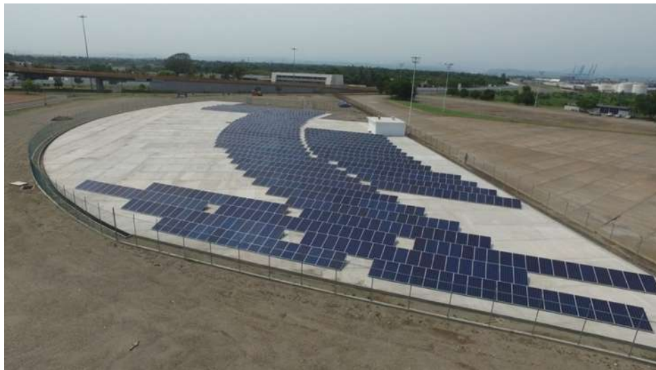
Figura 1-2.- Instalación de 1044 paneles [4]
