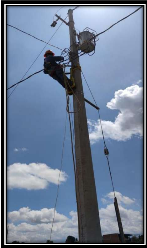
Figura 30: Instalación de transformador monofásico YT 10 KVA 13.2kv a 220/110.
