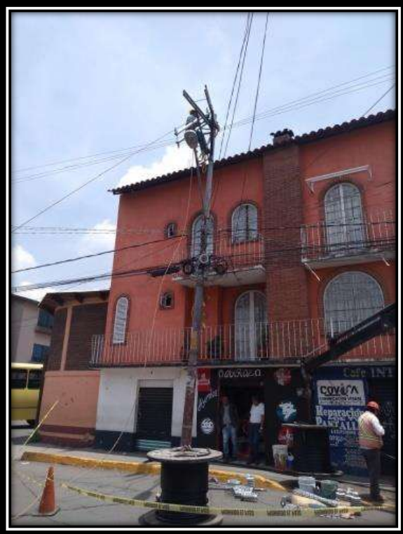
Figura 29: Tendido y tensionado de conductor SA-ACSR 336.
