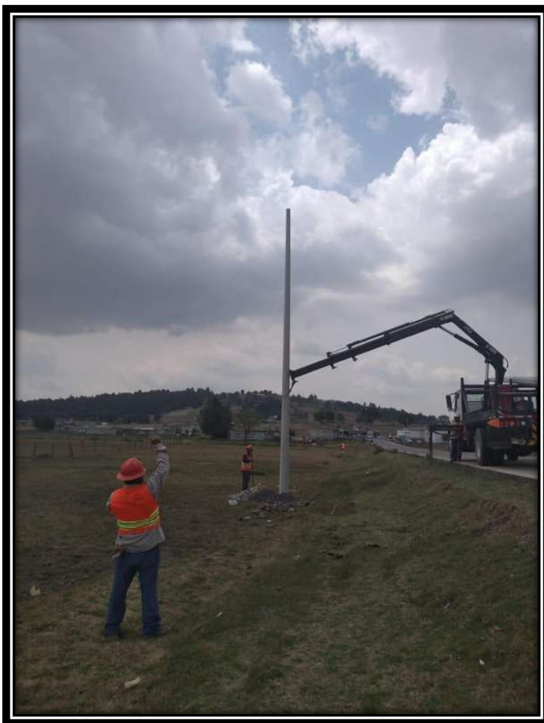
Figura 15: Plomeado de poste de concreto PCR13.
