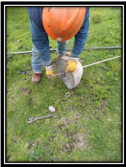
Figura 11: Armado de ancla cónica con perno ancla para instalación de retenida.
