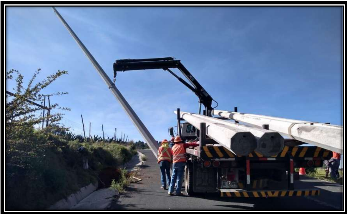
Figura 14: Hincado o empotramiento de poste con equipo hidráulico.
