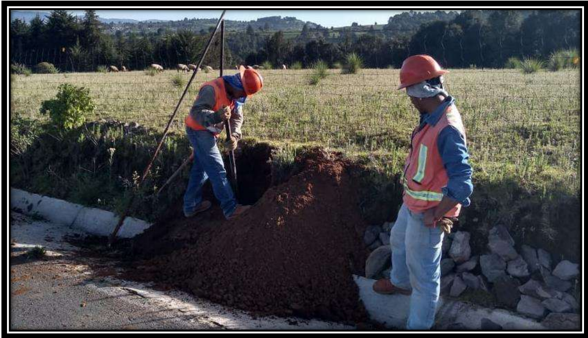
Figura 13: Excavación de cepa con herramienta manual, barra y cucharón
