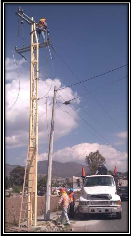
Figura 8: Torre Doble TD, vestida con 2 estructuras RD3N, Remate doble con 3 fases y neutro.
