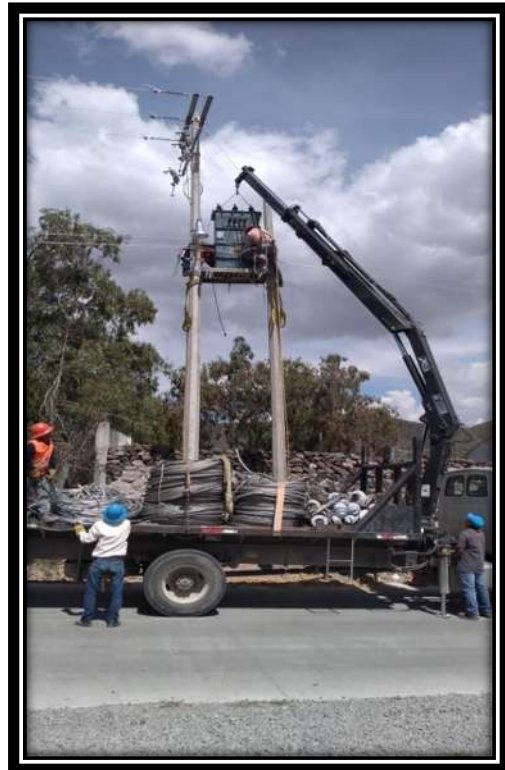
Figura 31: Instalación de transformador trifásico Delta-Estrella 23 KV a 220/127V.
