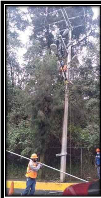
Figura 32: Instalación de Cuchillas de Operación en Grupo (COG)
