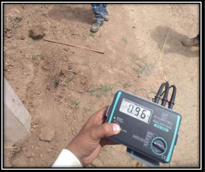
Figura 36: Medición de sistema de tierras en transformador tipo poste.
