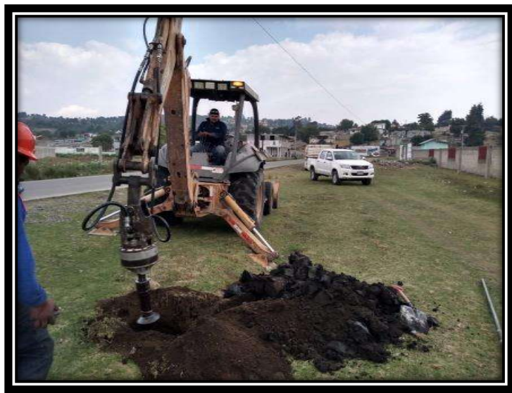
Figura 12: Excavación de cepa con broca barrenadora hidráulica adaptada a retro-excavadora
