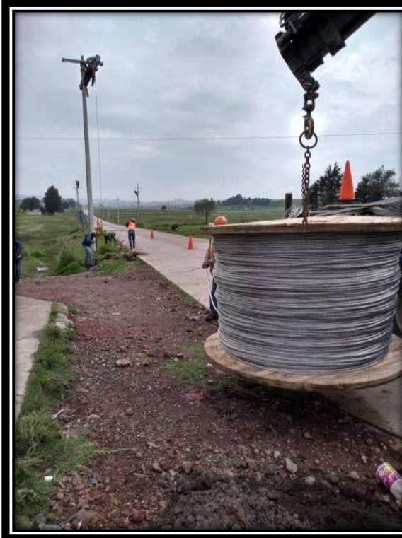
Figura 28: Tendido y tensionado de conductor desnudo ACSR 1/0.
