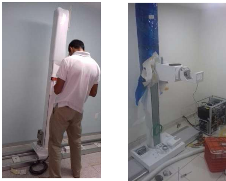
Figura 2.8 Columna montada en su base
