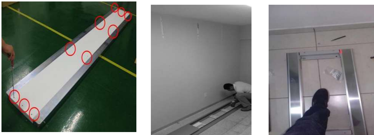
Figura 2.6 Fijación del riel
