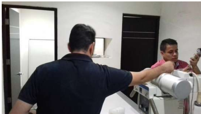
Figura 2.10 lubricación de los cables de alta para evitar arcos eléctricos
