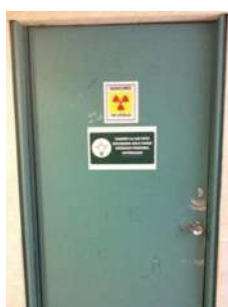
Figura 2.4 Puerta de acceso a una sala de rayos X.
