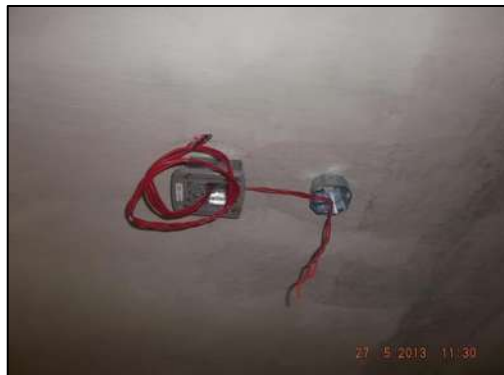
Figura 5.13 Remate de tubería e instalación de Sensor y Estrobo/Sirena
