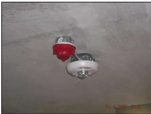
Figura 5.14 Remate de tubería e instalación de Sensor y Estrobo/Sirena (continuación)
