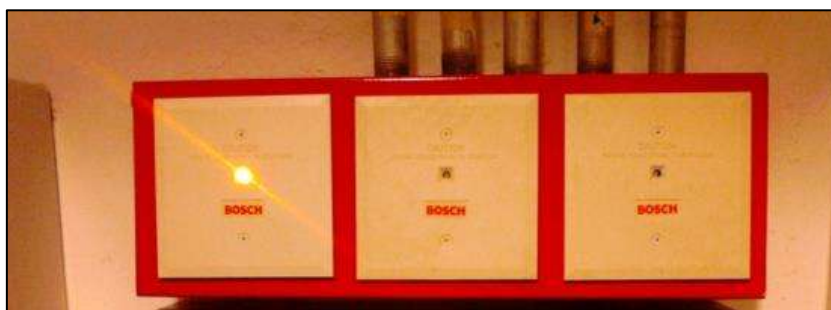
Figura 2.3 Dispositivo FLM-325-ISO activado por sobrecorriente
