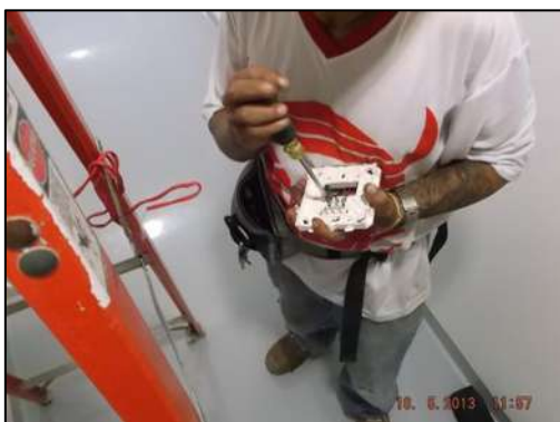
Figura 5.19 Revisión de Estrobos/Sirenas
