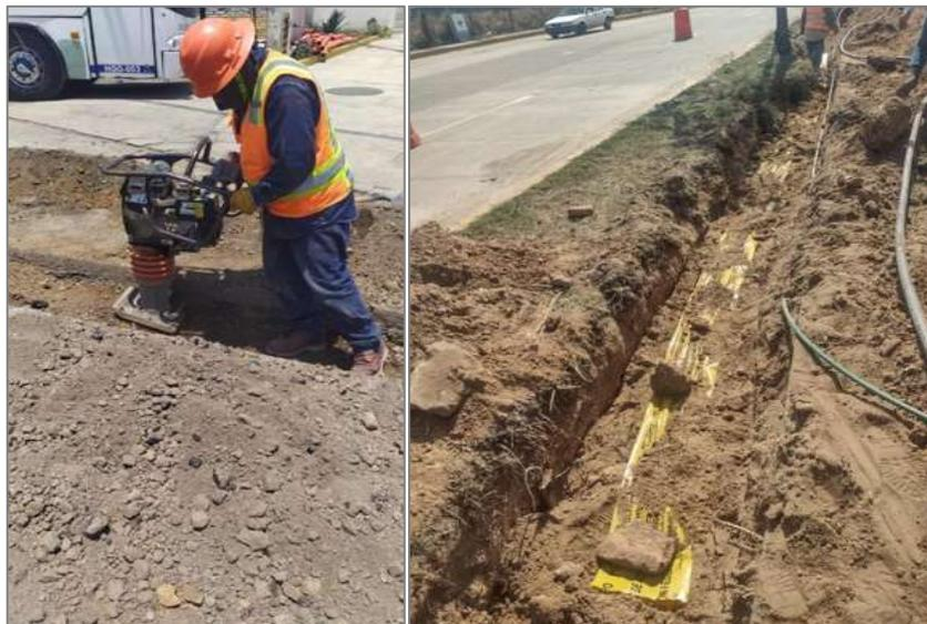
Figura 3.24.- Compactación de zanja e instalación de cinta
