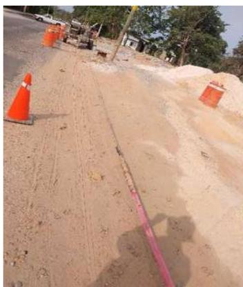
**Figura 4.15.- Salida del conductor en último registro**
