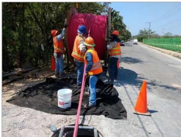
**Figura 4.12.- Instalación de cable en ductería**
