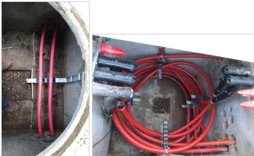
**Figura 4.16.- Cable en registro (De paso) y Cable en registro (Coca)**
