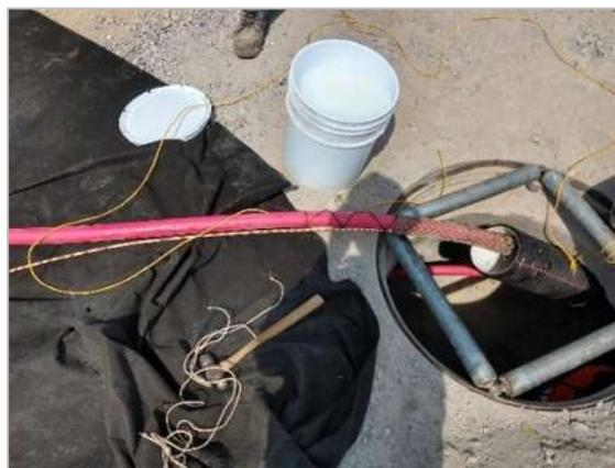
**Figura 4.13.- Aplicación de gel lubricante**
