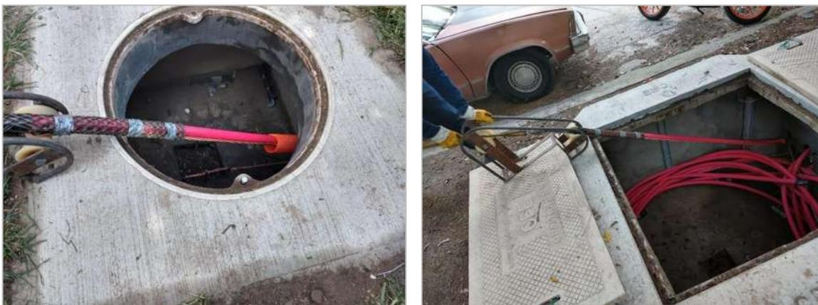
**Figura 4.9.- Colocación de poleas tipo banco**
