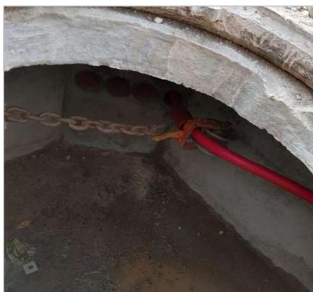
**Figura 4.8.- Colocación de polea con deflexión**
