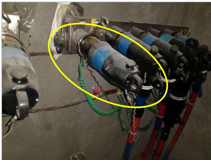
**Figura 4.35.- Tapón Aislado OCC 25 KV Instalado**
