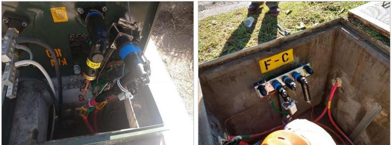
Figura 4.29.- Instalación Codo Apartarrayos
