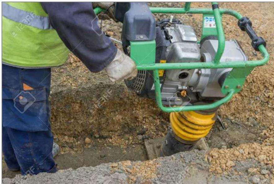
**Figura 3.20.- Compactación de fondo de zanja con bailarina,** Tomado de [https://es.123rf.com/photo\\_41554515\\_trabajador-con-pis%C3%B3n-zanja-compactar-la-ropa-de-cama-de-arena-se-extendi%C3%B3-a-lo-largo-del-fondo-de-la.html](https://es.123rf.com/photo_41554515_trabajador-con-pis%C3%B3n-zanja-compactar-la-ropa-de-cama-de-arena-se-extendi%C3%B3-a-lo-largo-del-fondo-de-la.html)
