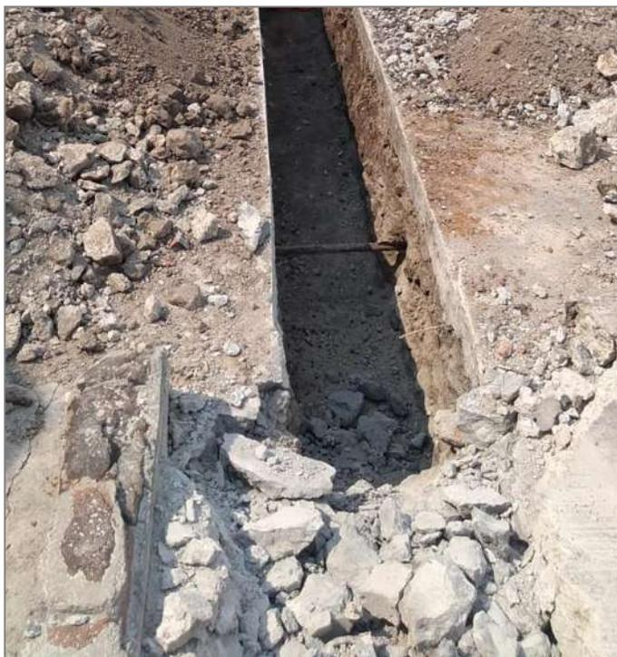
**Figura 3.21.- Zanja preparada para recibir ductos**
