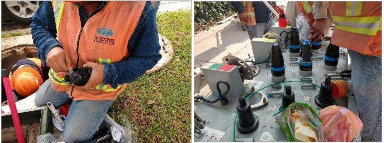
Figura 4.31.- Instalación boquilla tipo inserto
