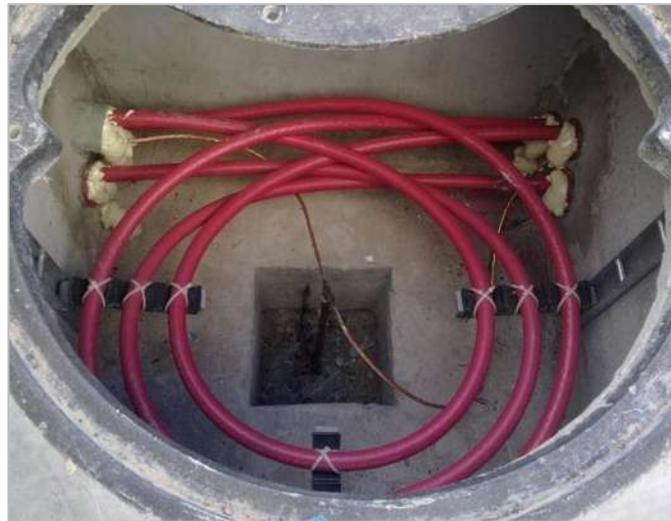
Figura 4.20.- Acomodo y fijación de cable sobre aislador de neopreno.
