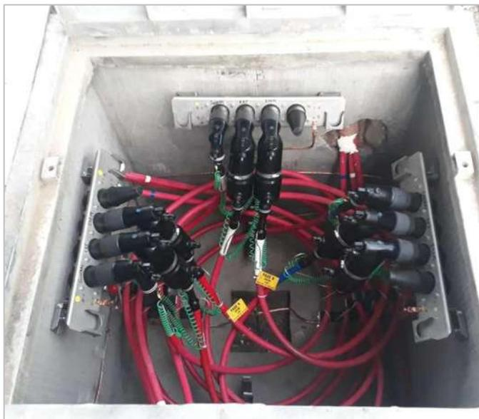
Figura 4.33.- Instalación real Derivador en Bóveda
