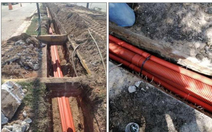
**Figura 3.22.- Instalación de ductería corrugada**
