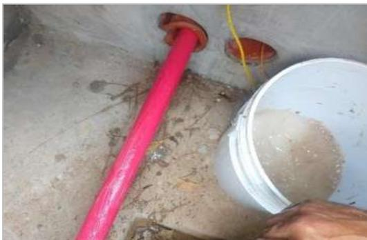
**Figura 4.14.- Aplicación de gel lubricante en registros**
