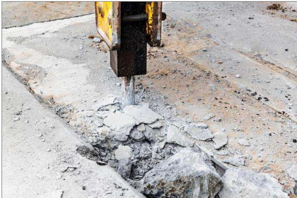
Figura 3.2.- Demolición con martillo hidráulico, Tomado de: <https://shorturl.at/qsDN5>
