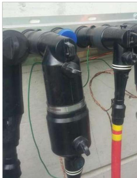
**Figura 4.26.- Elaboración y terminado de codo porta fusible**
