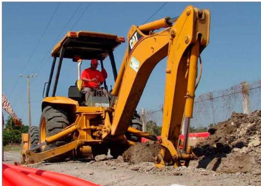
Figura 3.19.- Excavación de zanja, Tomado de <https://instalacioneselctricasresidenciales.blogspot.com/2013/03/2-configuraciones-de-las-redes.html>
