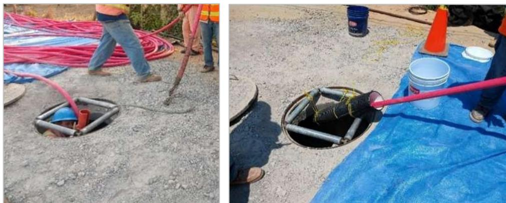
Figura 4.6.- Colocación de poleas en aro de registro
