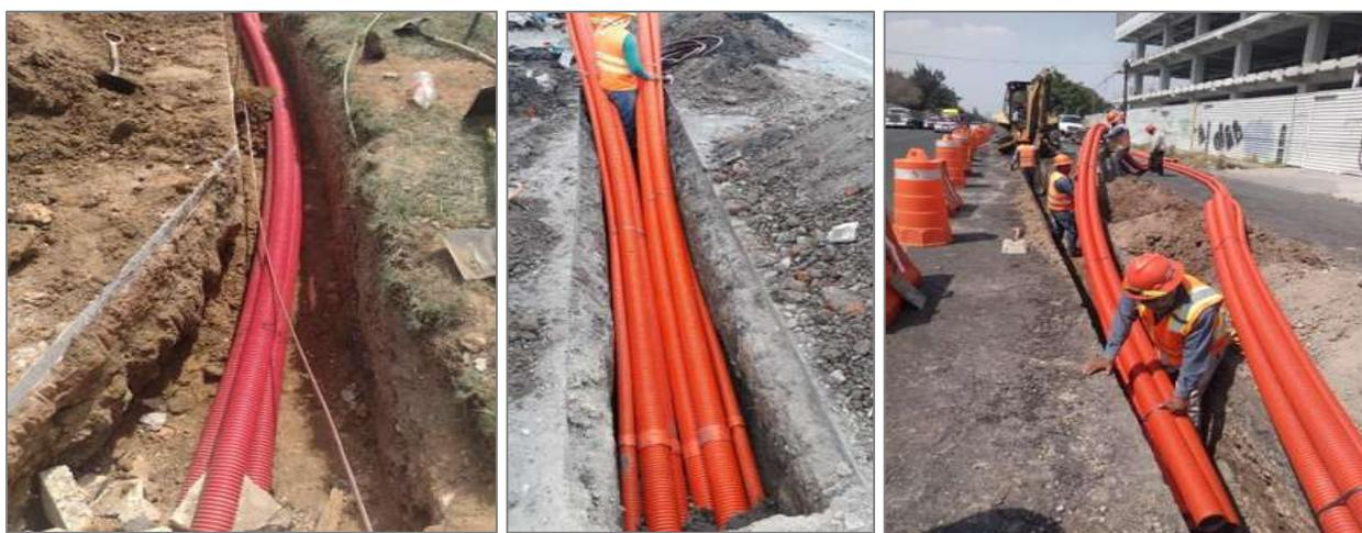
**Figura 3.23.- Instalación de ductería**
