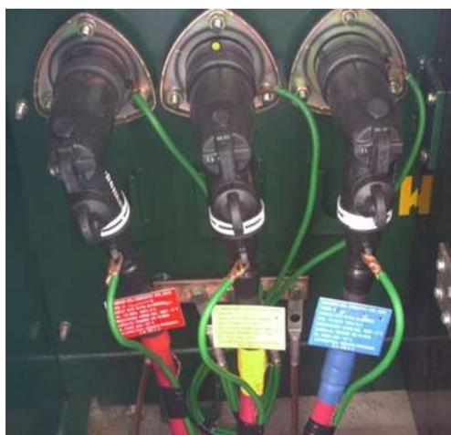
Figura 4.38.- Placa trovicel Fase A, B y C, Tomado de [http://electroconstructoraenaltaybajatenension.mex.tl/photo\\_im000067-jpg.html](http://electroconstructoraenaltaybajatenension.mex.tl/photo_im000067-jpg.html)
