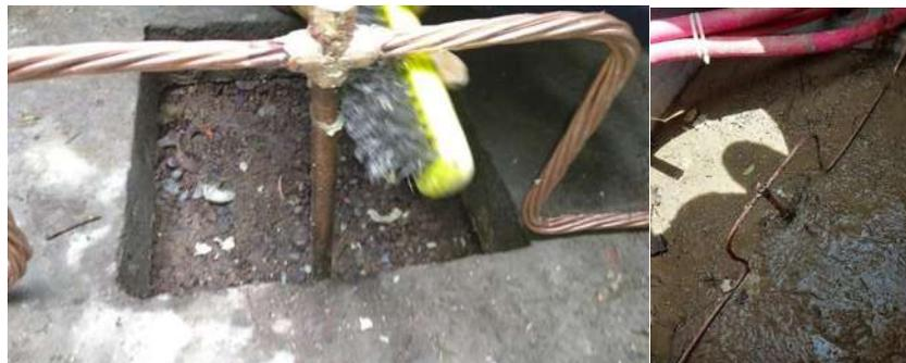
Figura 4.21.- Conexión soldable y varilla de tierra
