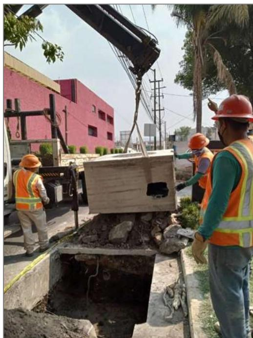
Figura 3.33.- Instalación de registro de media tensión
