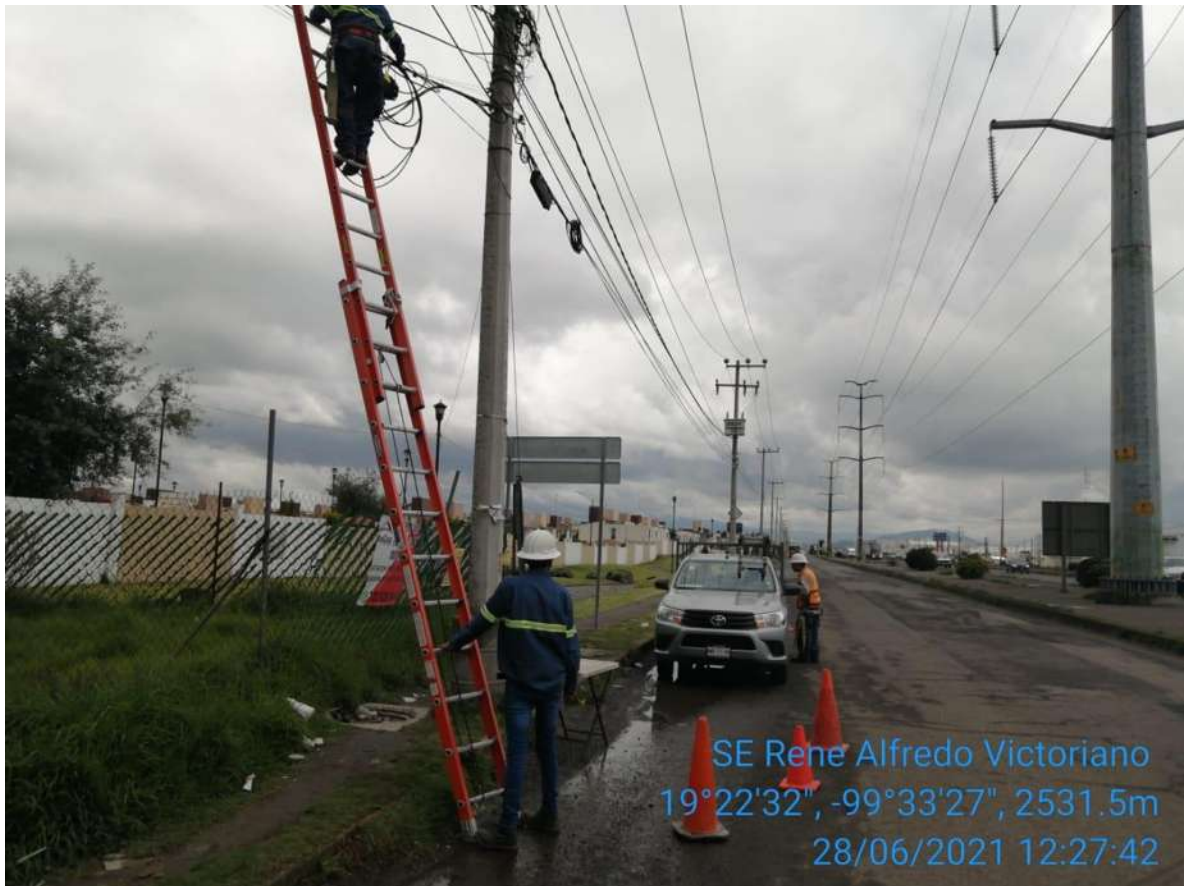
FIGURA 31.- CONSTRUCCIÓN DE RED DE FIBRA ÓPTICA.
