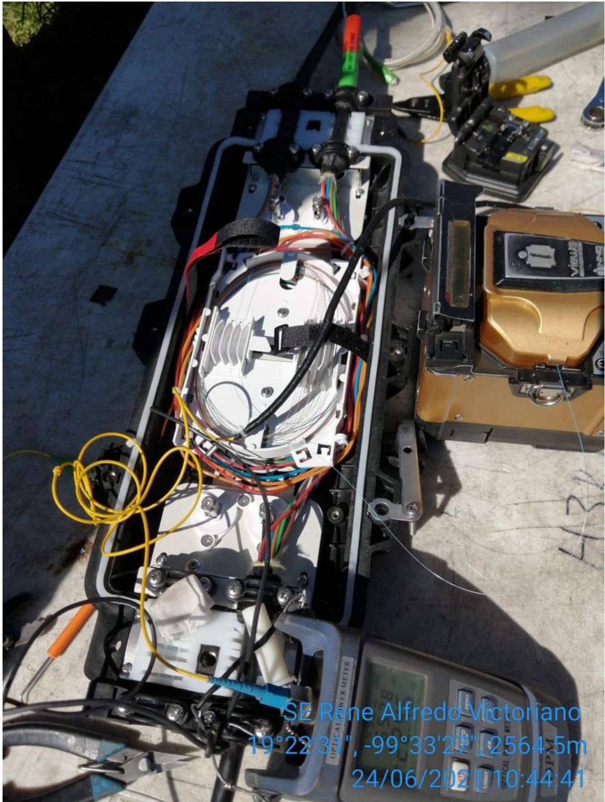
FIGURA 36.- REALIZACIÓN DE CIERRES DE EMPALME DE CONTINUIDAD.
