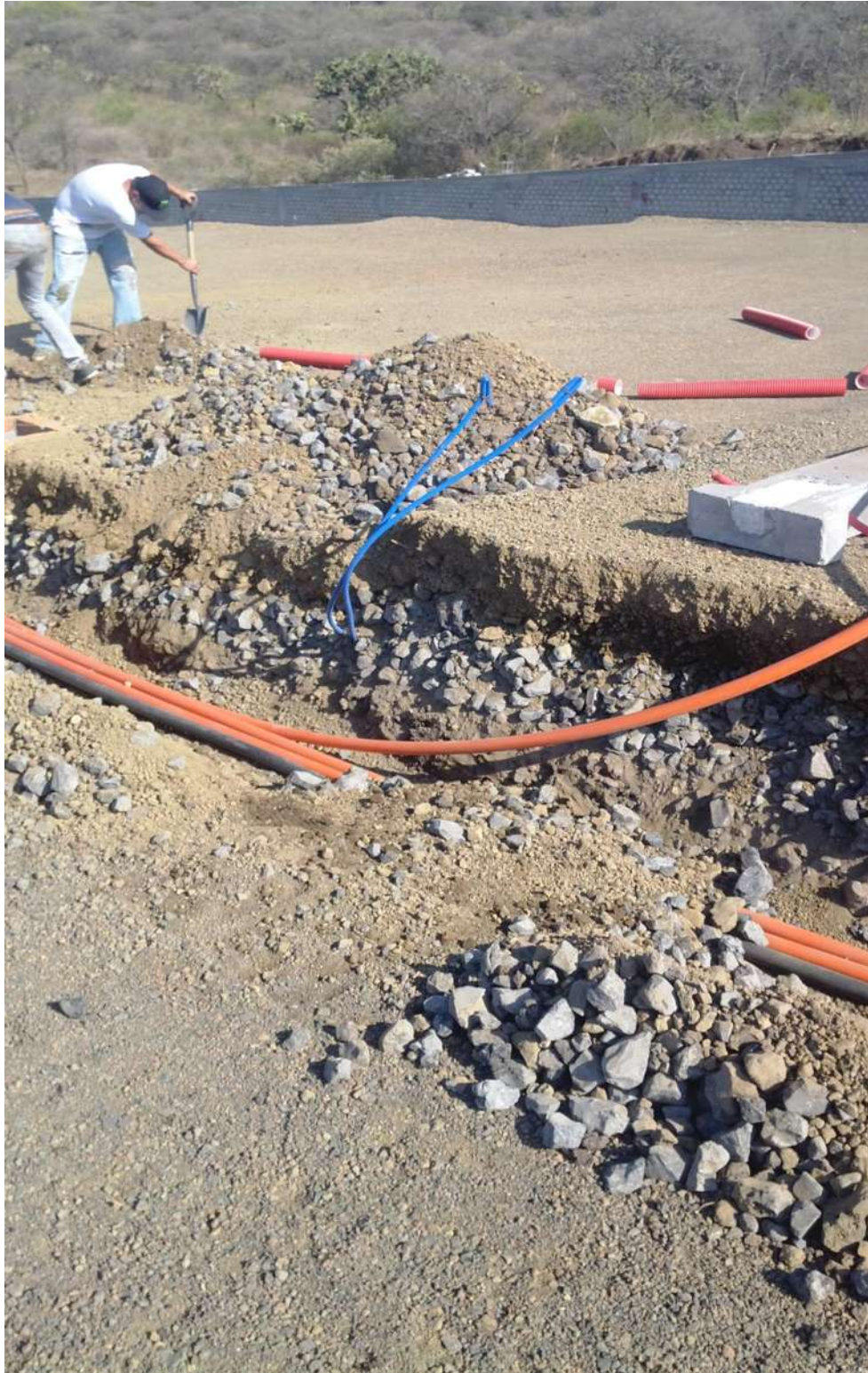
FIGURA 21.- INSTALACIÓN DE DUCTOS BAJA TENSIÓN.
