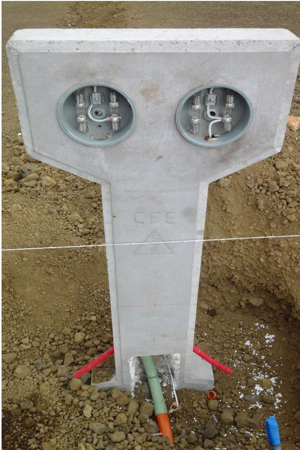
FIGURA 28.- INSTALACIÓN DE TIERRAS EN MURETES DE MEDICIÓN.
