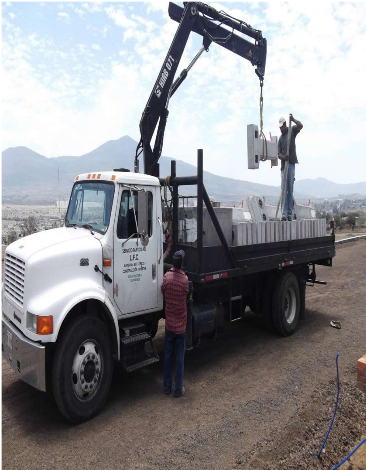
FIGURA 23.- INSTALACIÓN DE MURETES DE MEDICIÓN.
