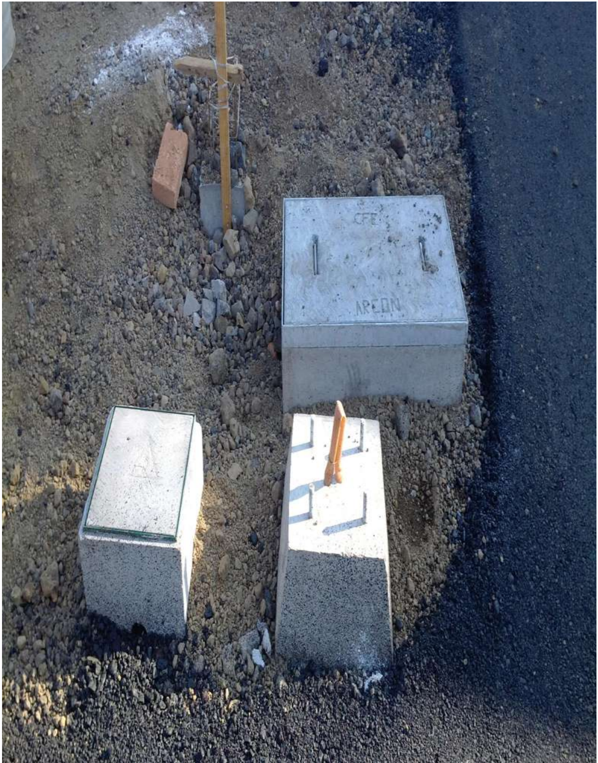
FIGURA 24.- INSTALACIÓN DE DUCTOS ALUMBRADO Y MURETES DE MEDICIÓN.
