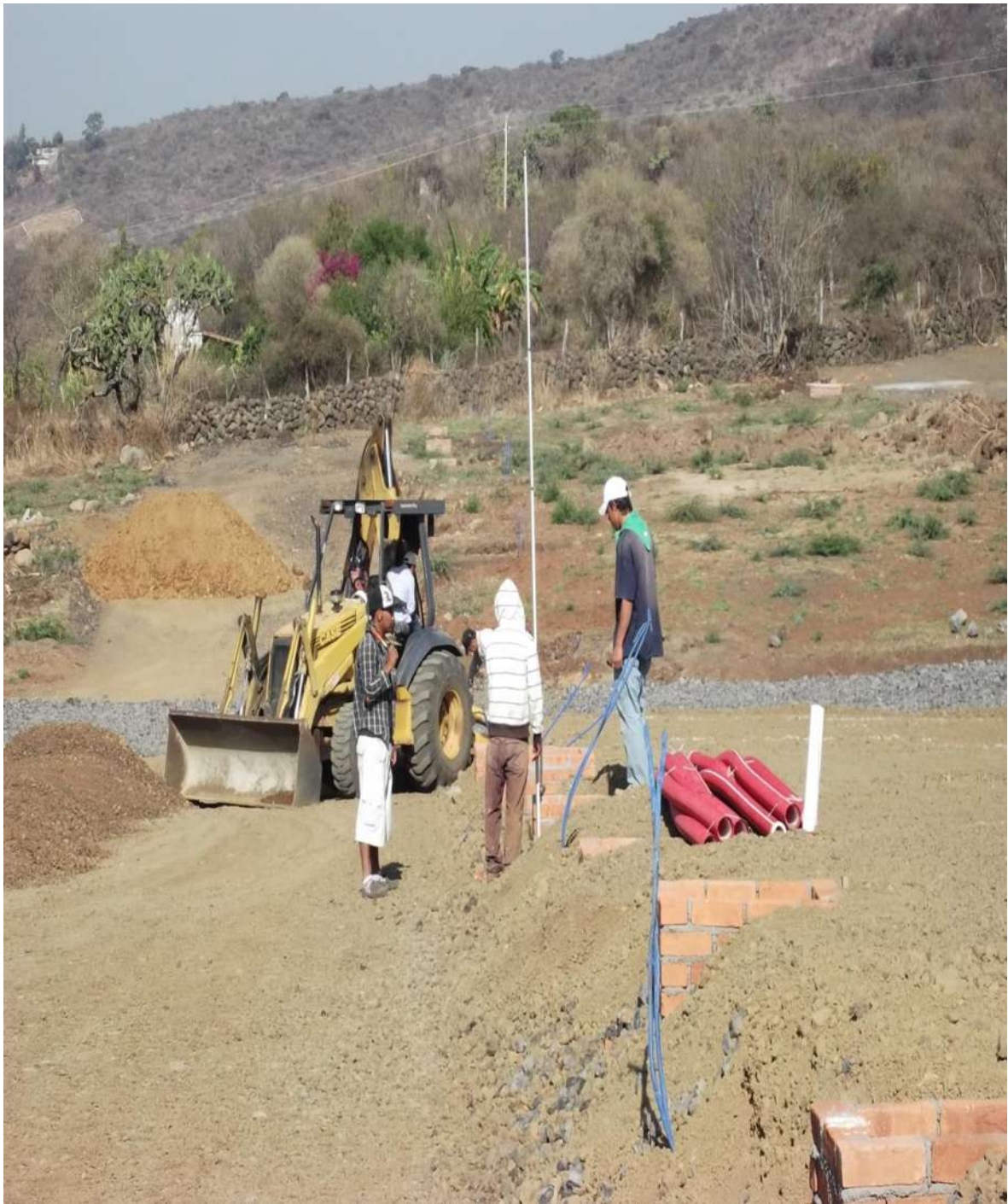
FIGURA 27.- INSTALACIÓN DE DUCTOS BAJA TENSIÓN.
