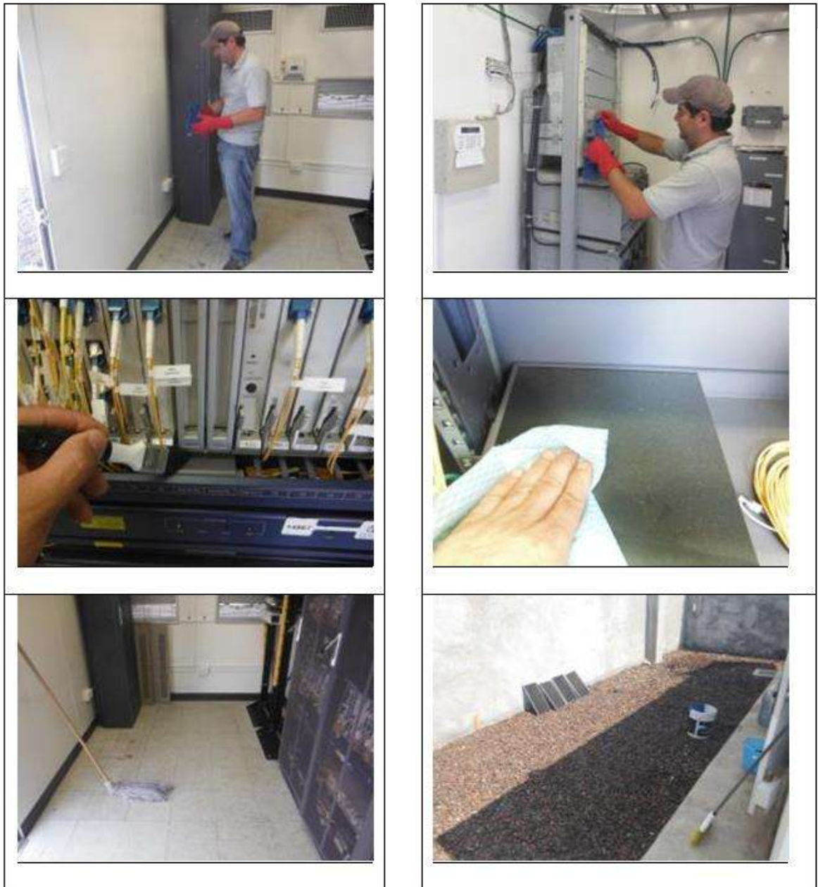
FIGURA 7.- LIMPIEZA DE EQUIPOS EN SITE.
