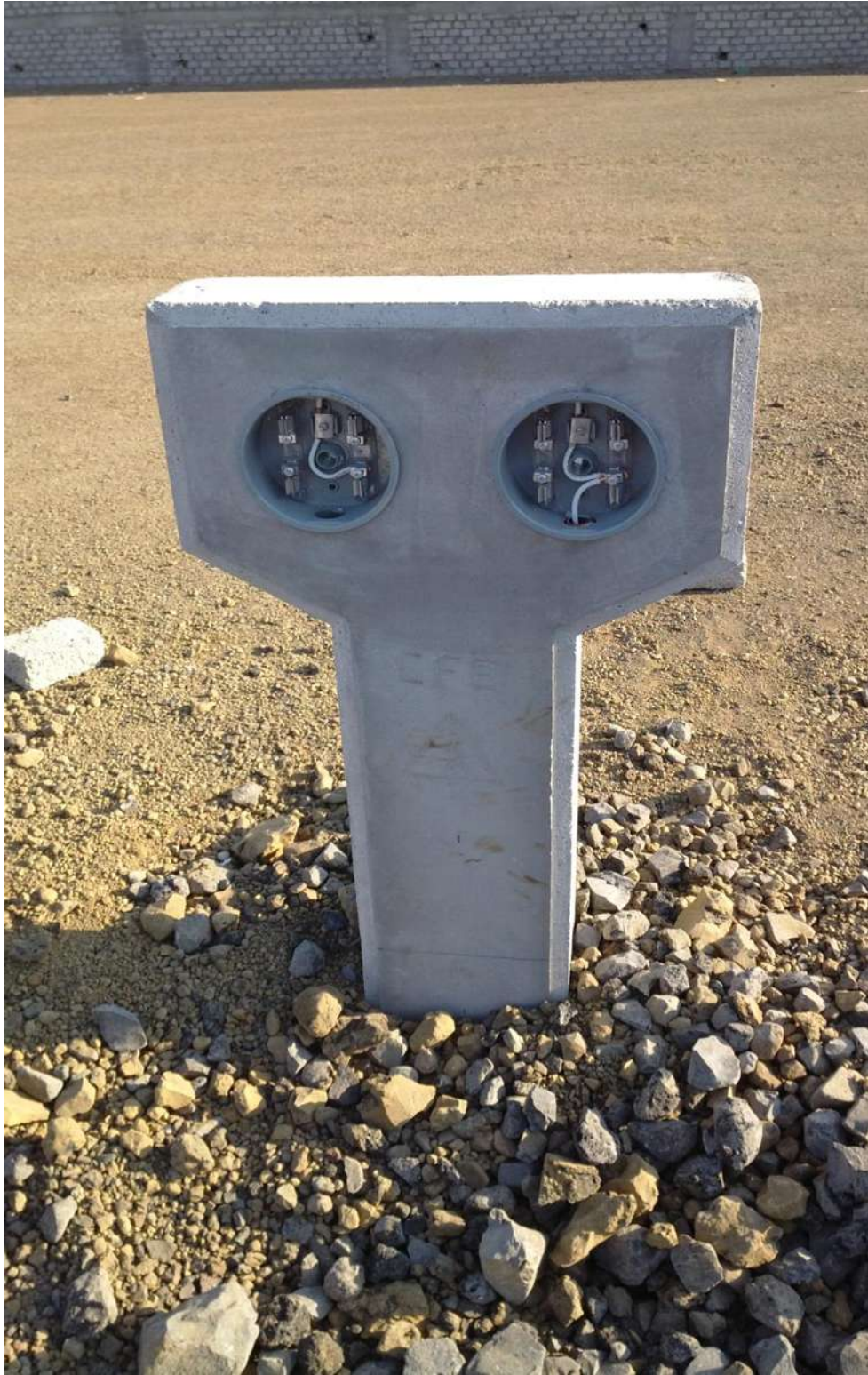
FIGURA 26.- INSTALACIÓN DE MURETES DE MEDICIÓN.
