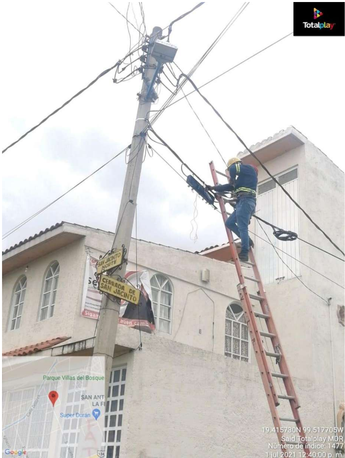
FIGURA 32.- CONSTRUCCIÓN DE RED DE FIBRA ÓPTICA.
