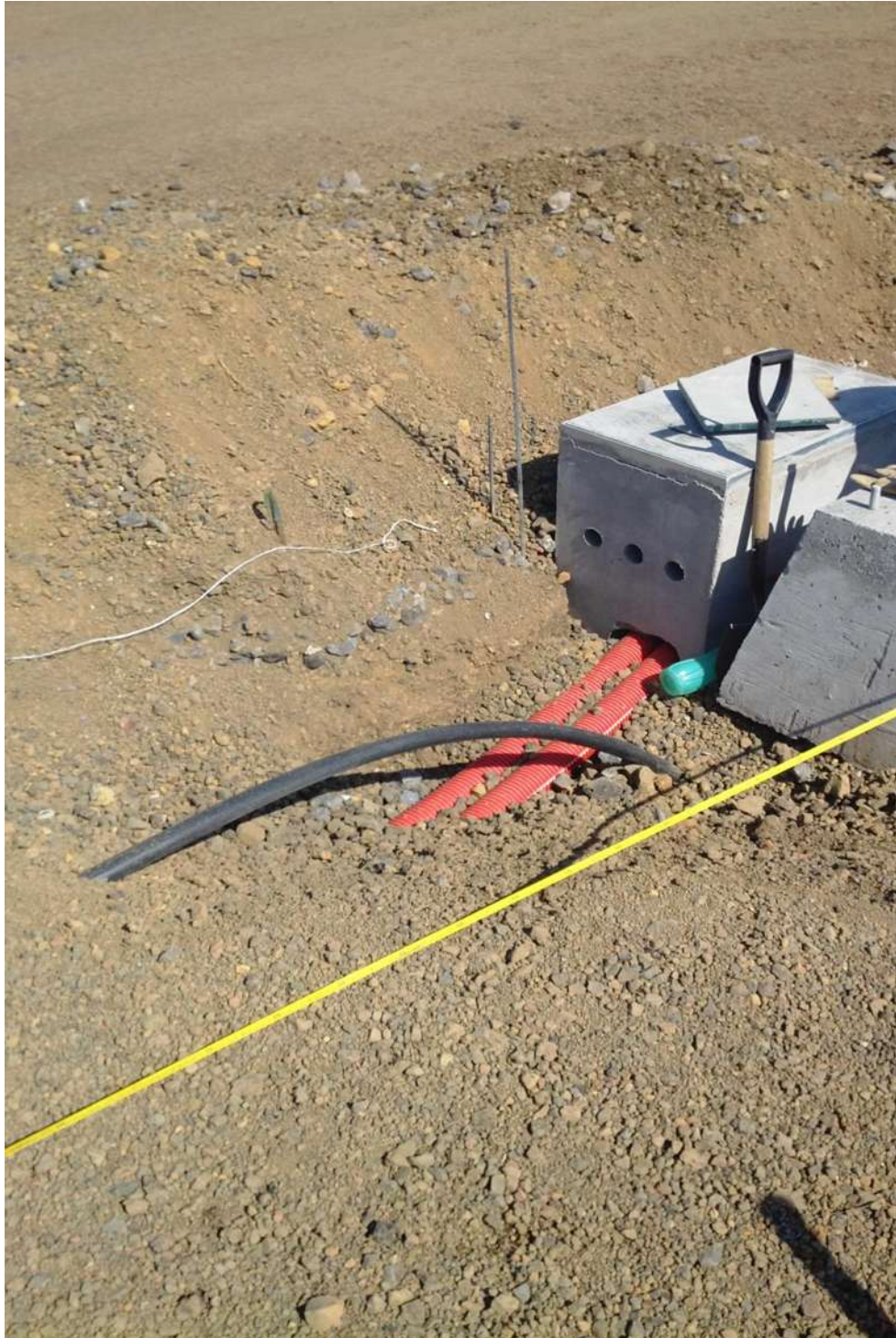
FIGURA 22.- INSTALACIÓN DE REGISTROS BAJA TENSIÓN.
