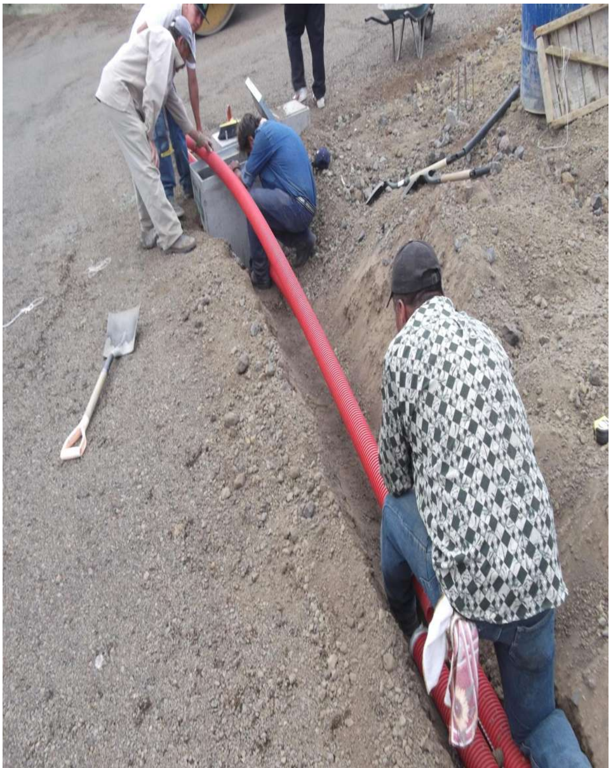
FIGURA 25.- INSTALACIÓN DE DUCTOS MEDIA TENSIÓN.
