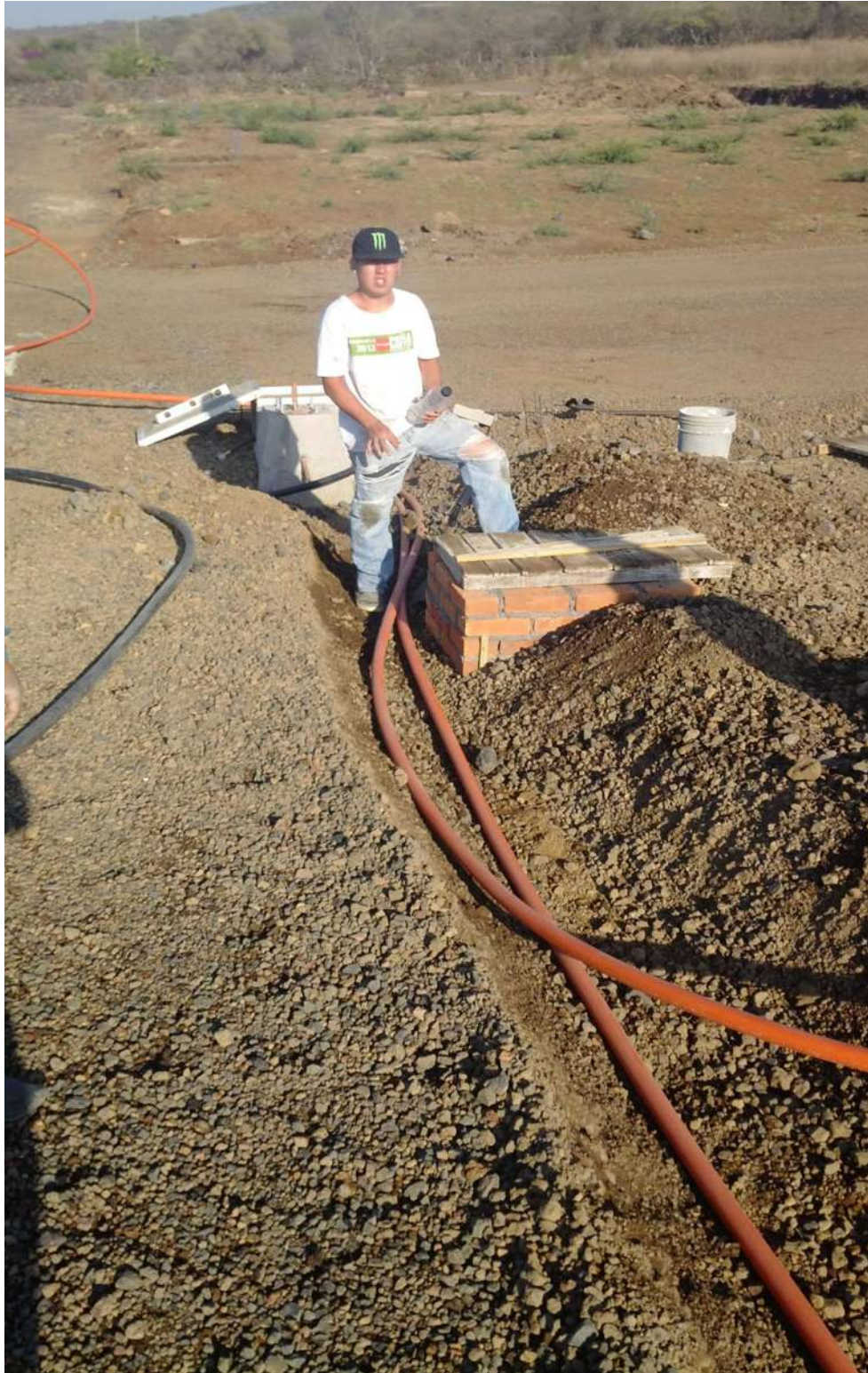
FIGURA 20.- INSTALACIÓN DE DUCTOS BAJA TENSIÓN.
