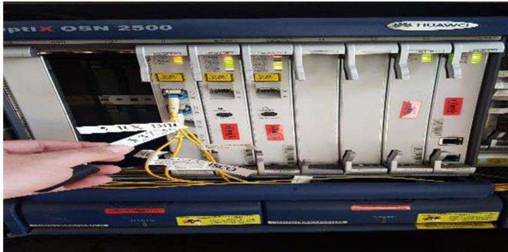
IDENTIFICADO Y ETIQUETADO DE FIBRAS EN EQUIPO DESPUÉS
