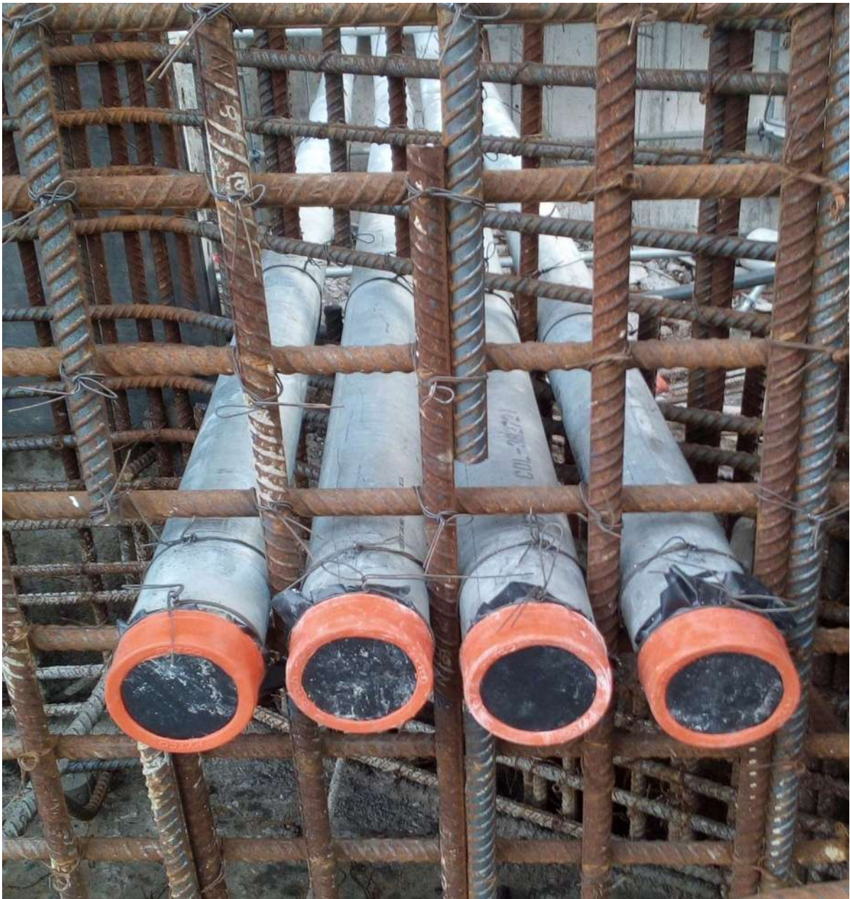
Figura 24.- Las Canalizaciones trabajo Constructivo.
