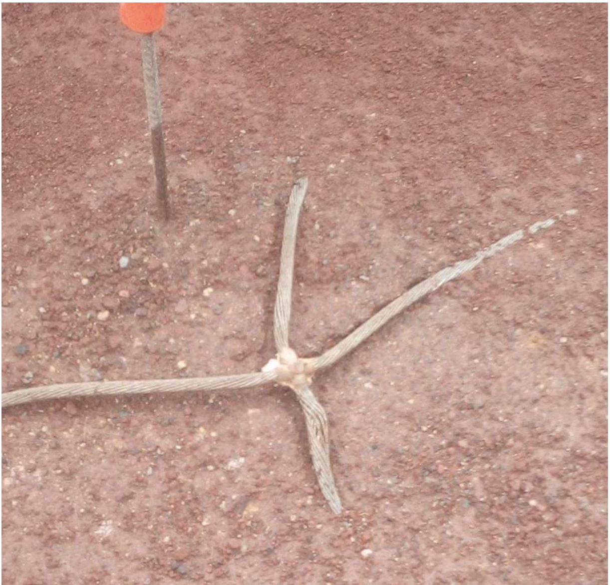
Figura 31.- Soldadura Exotérmica trabajo constructivo.
