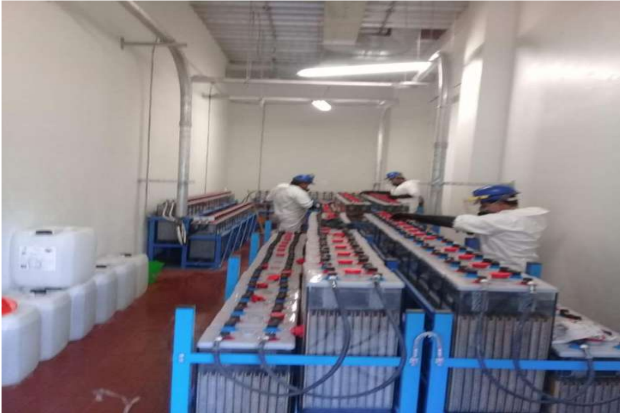
Figura 28.- El Montaje de equipos eléctrico trabajo constructivo.
