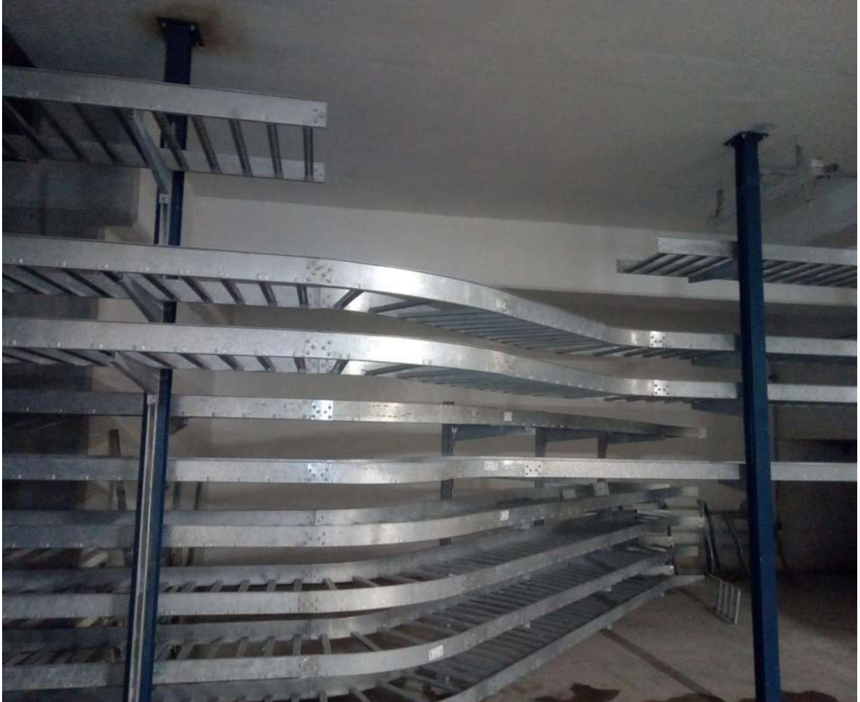
Figura 26.- Las Canalizaciones trabajo Constructivo.
