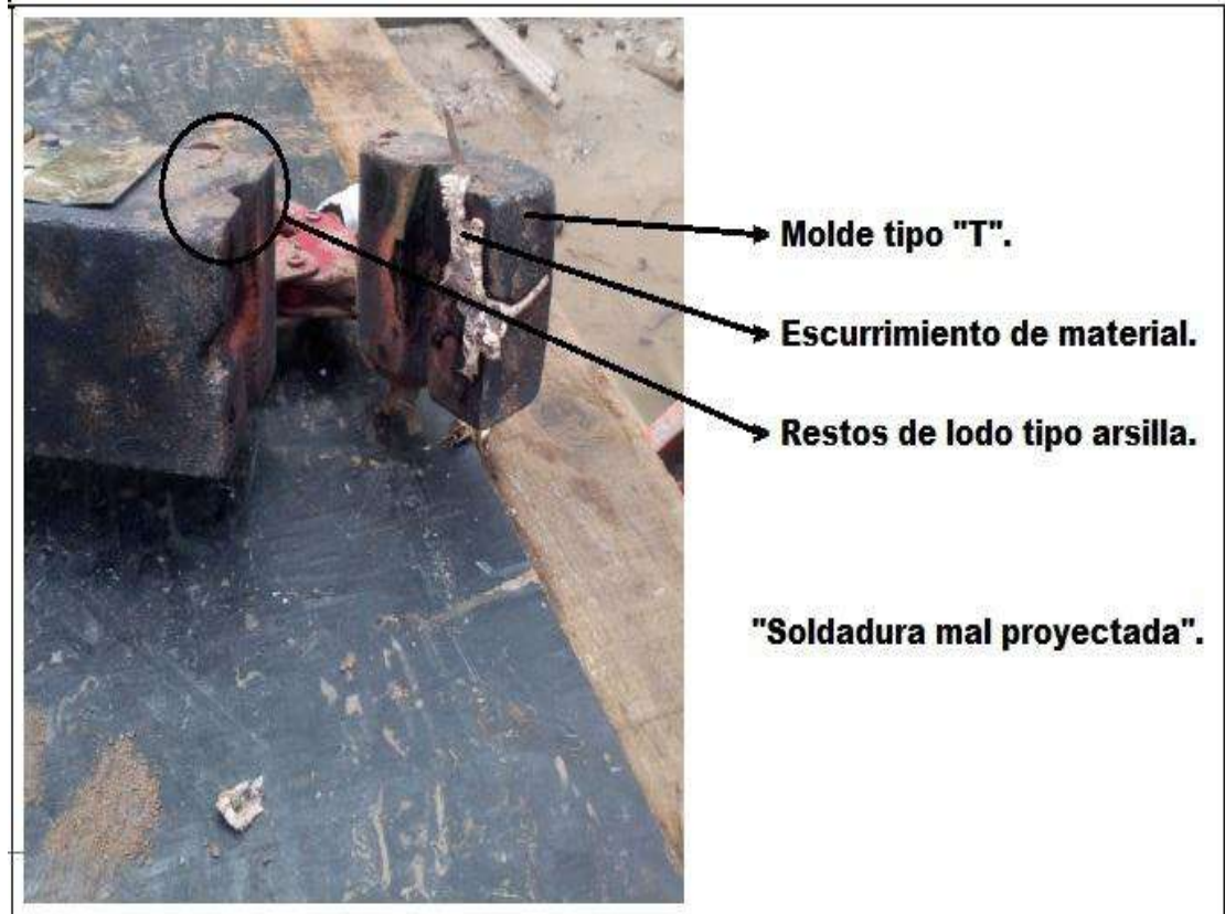
Figura 34.- Soldadura Exotérmica trabajo constructivo.
