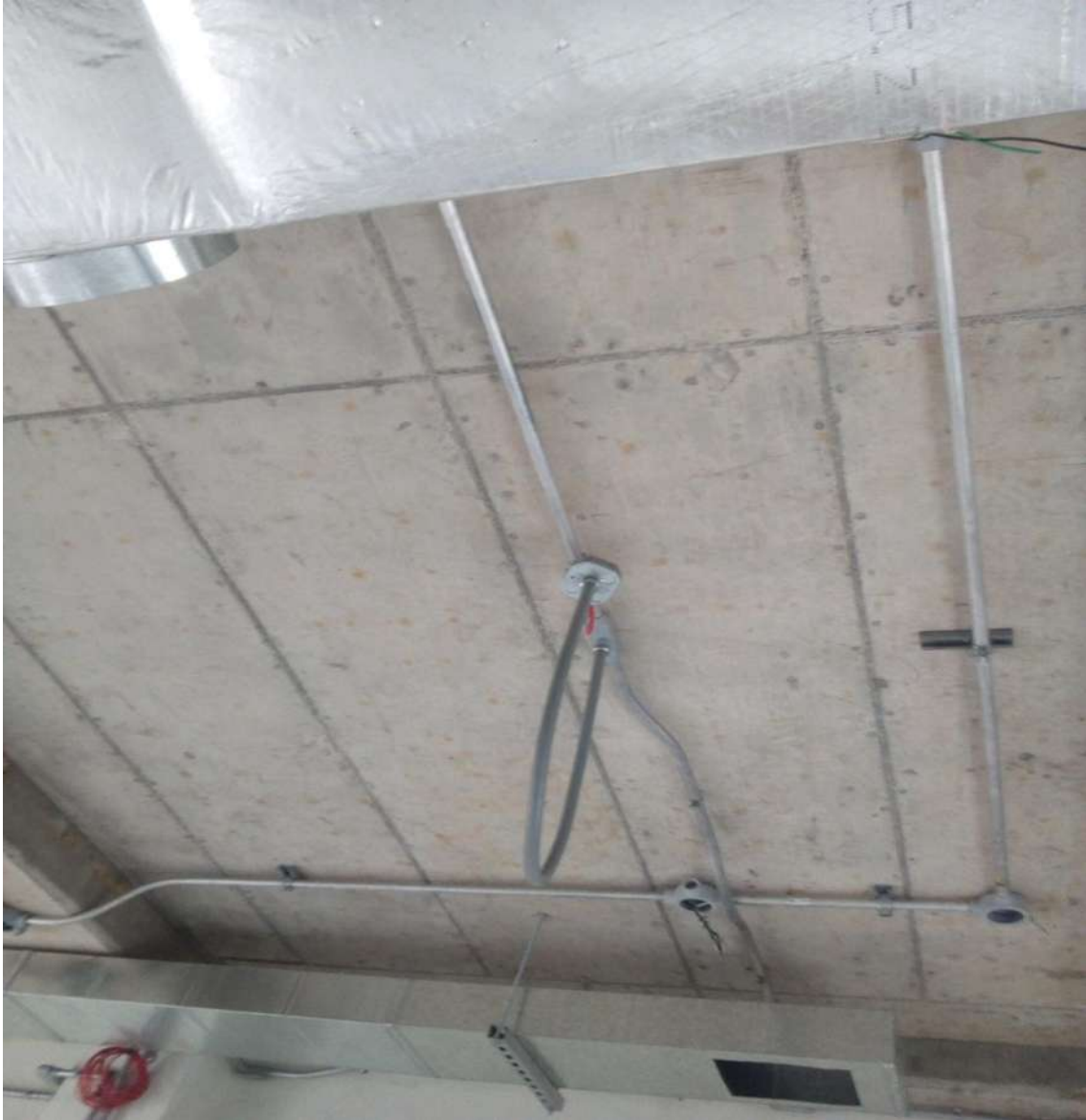
Figura 25.- Las Canalizaciones trabajo Constructivo.
