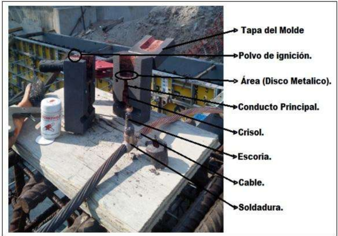
Figura 33.- Soldadura Exotérmica trabajo constructivo.
