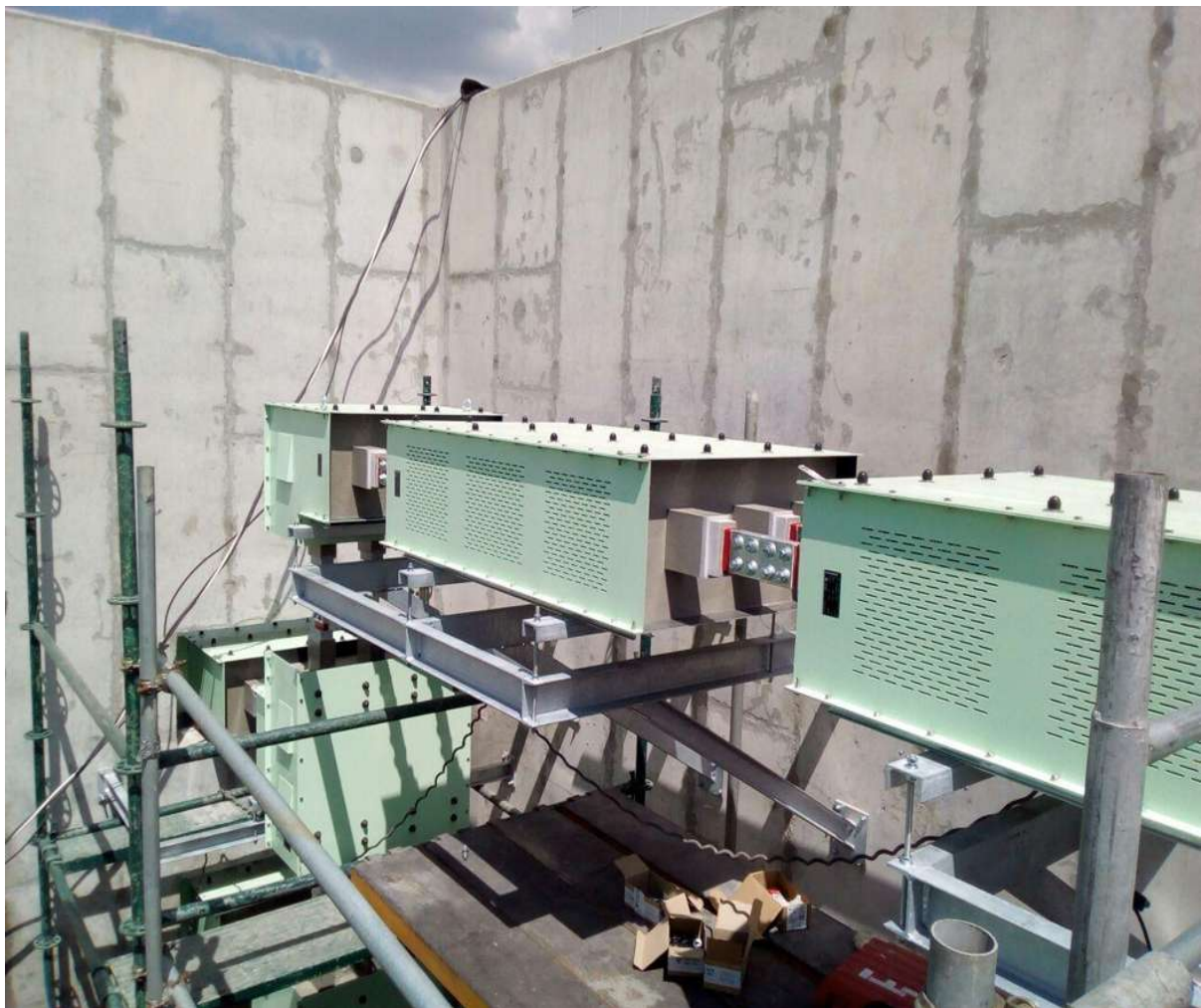
Figura 27.- El Montaje de equipos eléctrico trabajo constructivo.
