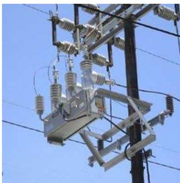
*Figura 4.4 Seccionalizador.*
