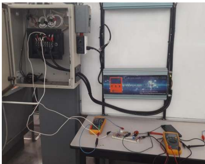
Figura 5. 17 Conexión del convertidor al panel fotovoltaico.
