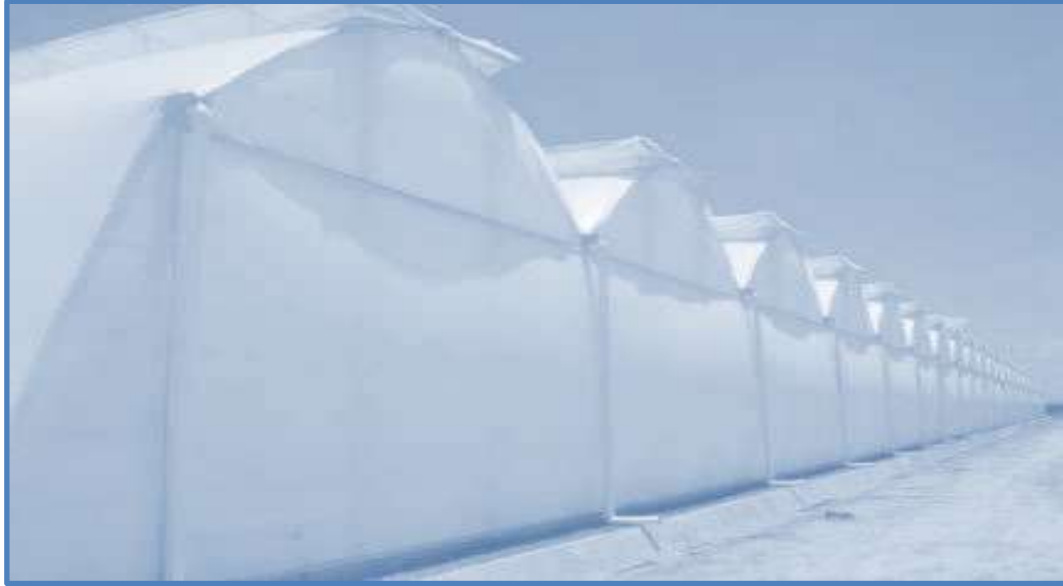
Figura 3.4 Ejemplo de estructuras de invernadero
