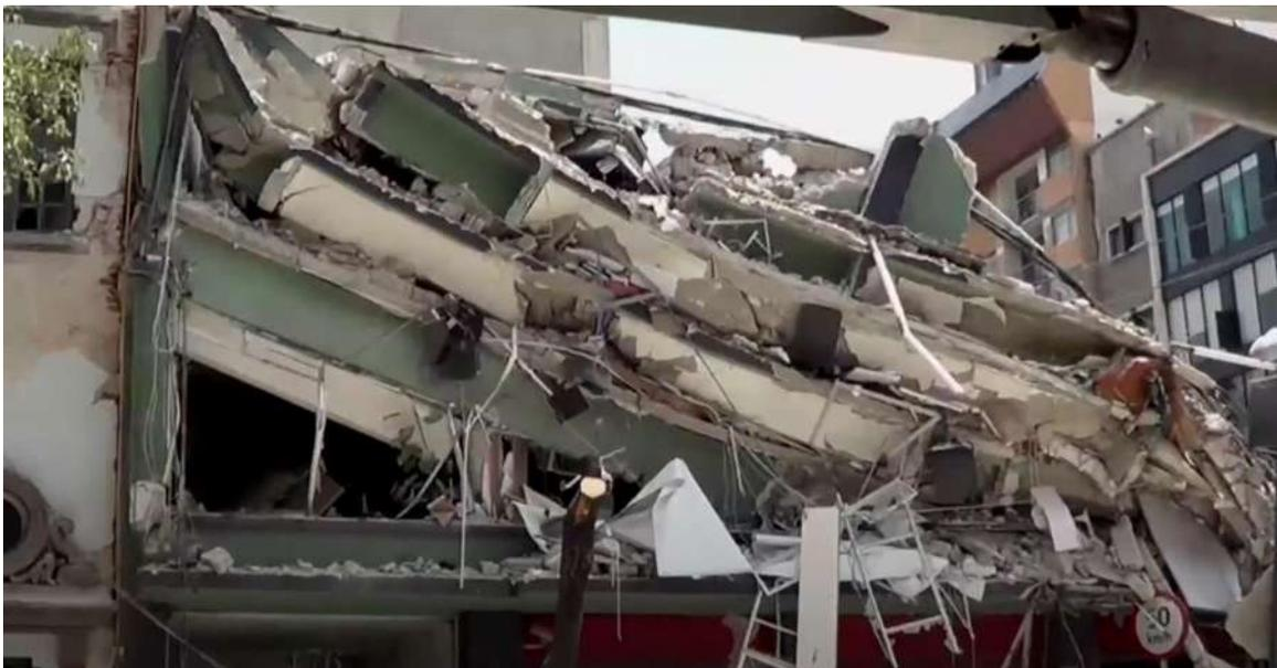
*Figura 212 Colapso de las columnas por desplazamiento en la dimensión corta del nivel dos del edificio C11 de seis niveles*
