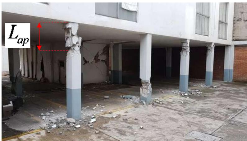
Figura 102 Longitud de articulación plástica en una columna dañada (García, F., 2019)
