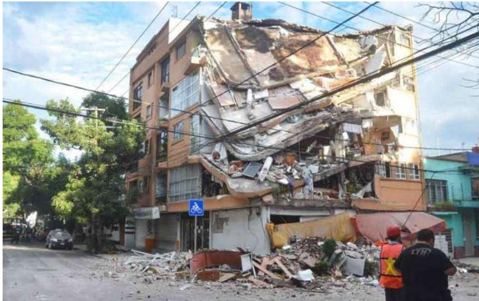
*Figura 211 Colapso parcial de las columnas en la esquina sin muros del nivel dos del edificio C3 de cinco niveles*
