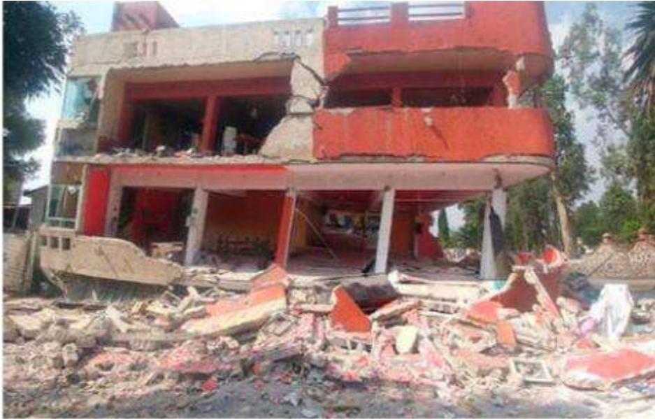
*Figura 210 Colapso en el nivel uno del edificio C10 de tres niveles*
