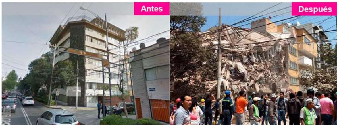
*Figura 4 Colapso provocado por torsión (Redacción, 2017)*
