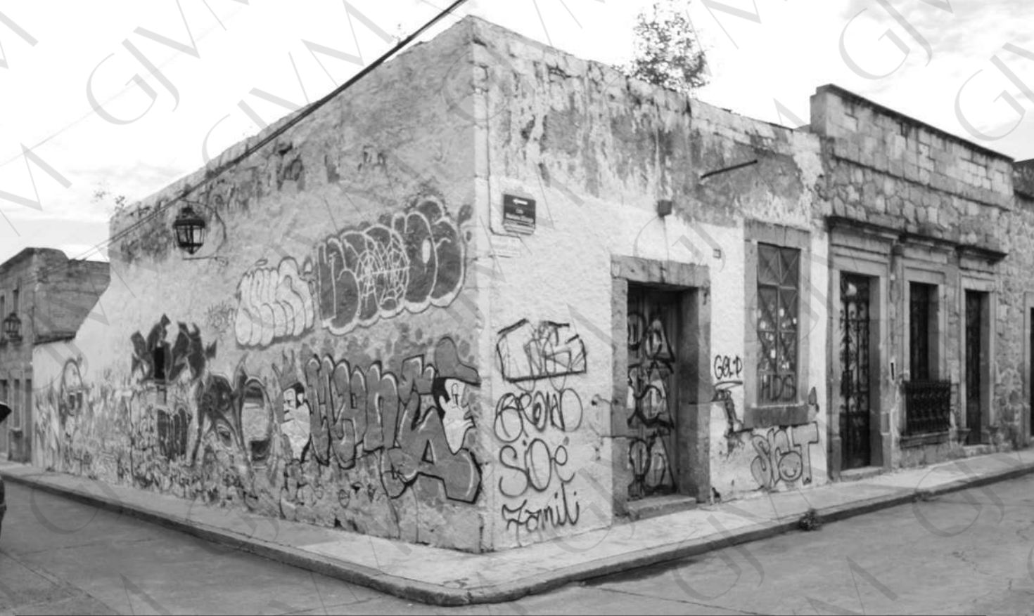
Imagen 62. Vivienda patrimonial en Riesgo sector Nueva España. Tomada por: Grecia Vargas.
