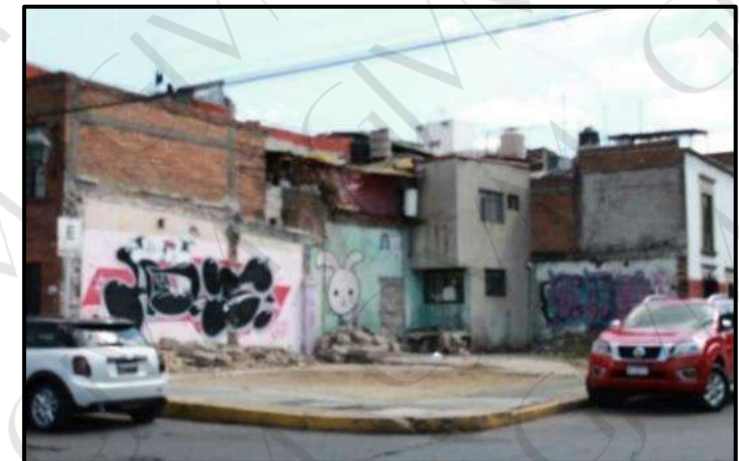
Imagen 13. Pérdida de vivienda patrimonial debido a la falta de gestión de riesgos. Foto tomada por: Grecia Vargas.
