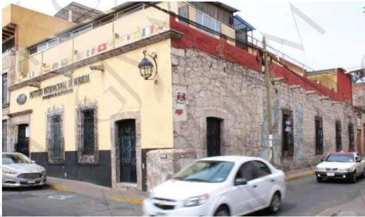
Imagen 45. Vivienda en estado de Riesgo Muy grave, en el sector Independencia. Foto tomada por: Grecia Vargas.
