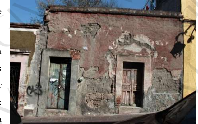
Imagen 33 y 34. Viviendas del Sector República habitadas por indigentes. Fuente: Grecia Vargas.
