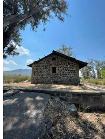
Ilustración 94. Fotografía de la rampa hacia el patio de maniobras de la estación, Enero del 2023, fuente: ACM
