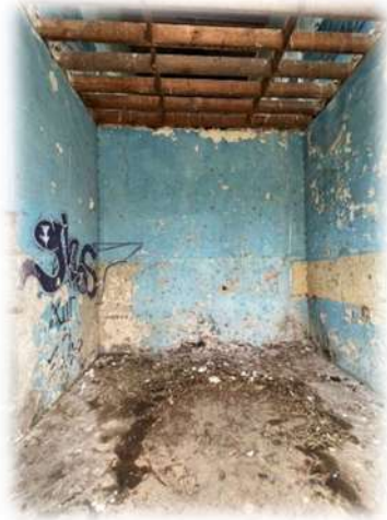
Ilustración 15. interior de la oficina de la estación, ACM, septiembre del 2022
