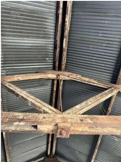
Ilustración 101. Detalle de estructura de pendolón y largueros en la bodega, diciembre del 2022, ACM
