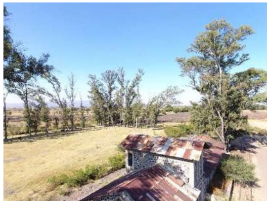
Ilustración 50. Fotografía aérea del conjunto hacia el nor este 03/12/2022 ACM
