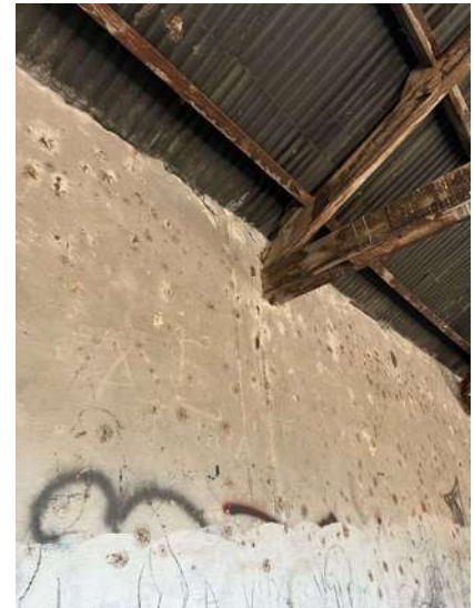
Ilustración 103. Detalle de la cubierta de la bodega, se observan hongos de pudrición blancos y cafés, enero del 2023, ACM
