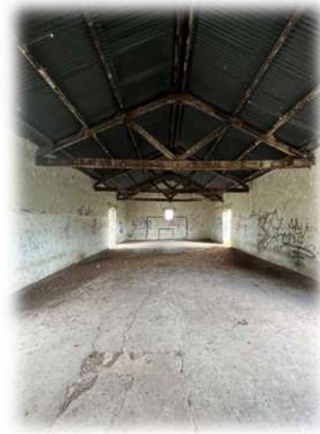
Ilustración 17. Fotografía del interior de la bodega, ACM, septiembre del 2022
