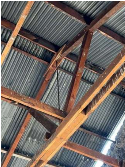
Ilustración 98. Fotografía de la armadura de pendolón de la sala de espera, Marzo 2023, Fuente: ACM
