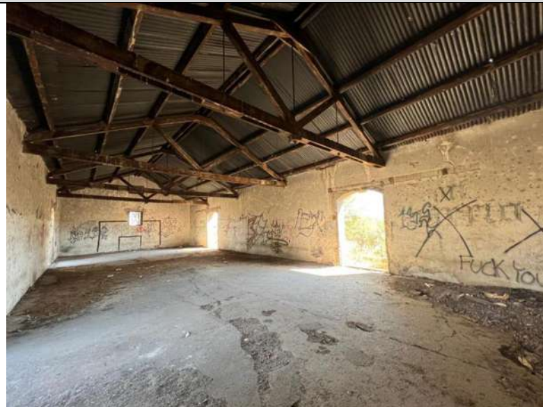
Fotografía del interior de la bodega donde se observa piso, muros y estructura de cubierta, Marzo del 2023, Fuente: Alfredo Cortes Muñoz
