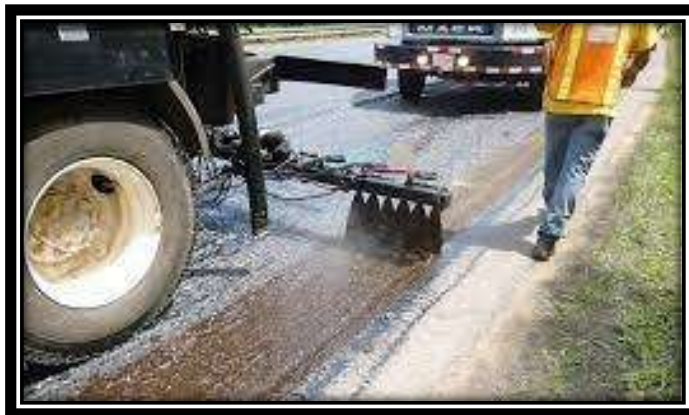
Fig. 19 Aplicación de emulsión asfáltica (Guerrero Aguilera, y otros, 2019)
