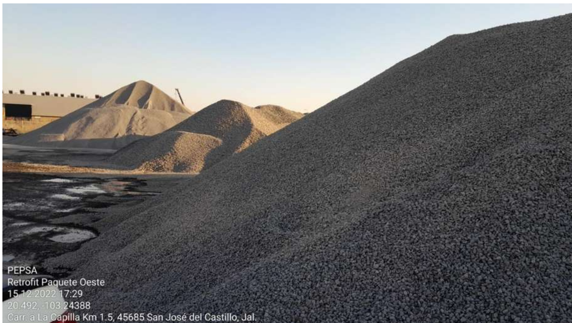
Figura 7. Acopio de agregados con talud o ángulo de reposo adecuado. Fuente: imagen capturada por autor.
