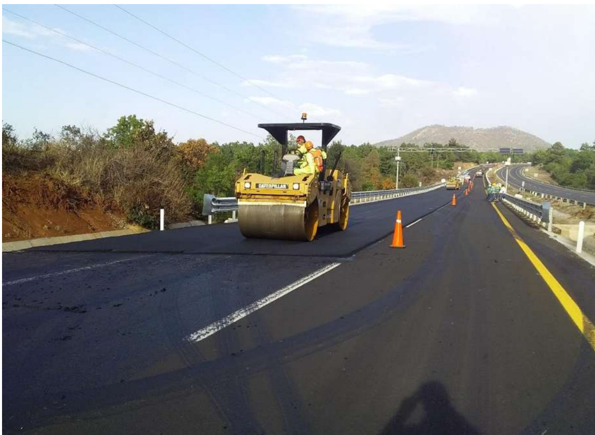
Figura 12. Proceso de compactación en tramo de prueba, autopista Patzcuaro-Uruapan. Fuente: imagen capturada por autor.
