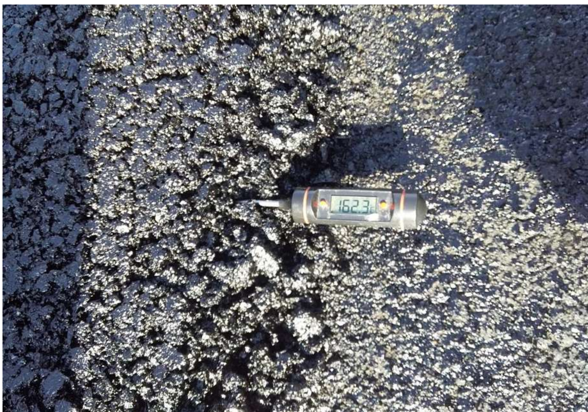
Figura 11. Comprobación de la temperatura de compactación en tramo de prueba, autopista Patzcuaro-Uruapan. Fuente: imagen capturada por autor.
