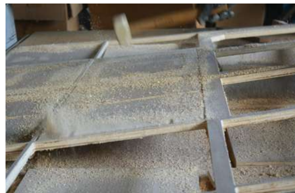
96. Proceso de fabricación. Cortes utilizando maquinaria CNC. YSAH.
