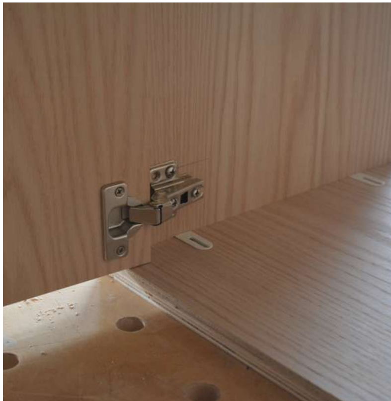
97. Armado de módulos y colocación de bisagras. YSAH.
