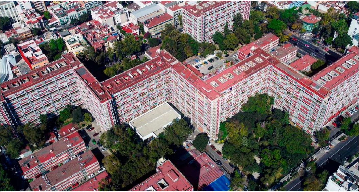
16. Vista aérea del CUPA. Fuente: Santiago Arau
