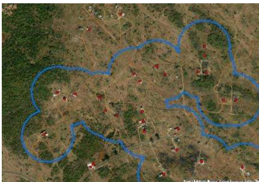
Figura 9: Ejemplo patrón de mínima proximidad entre infraestructuras civiles, zona noroccidental del área de estudio 2022. (Elaboración propia con base en imágenes satelitales Google Earth ).
