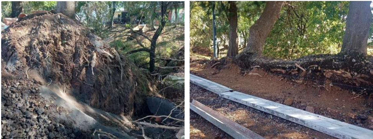
Figura 11. a) Perfil del talud donde se observa el relleno antropogénico, b) perfil perpendicular a la av. Solidaridad, donde se observa el relleno antropogénico.
