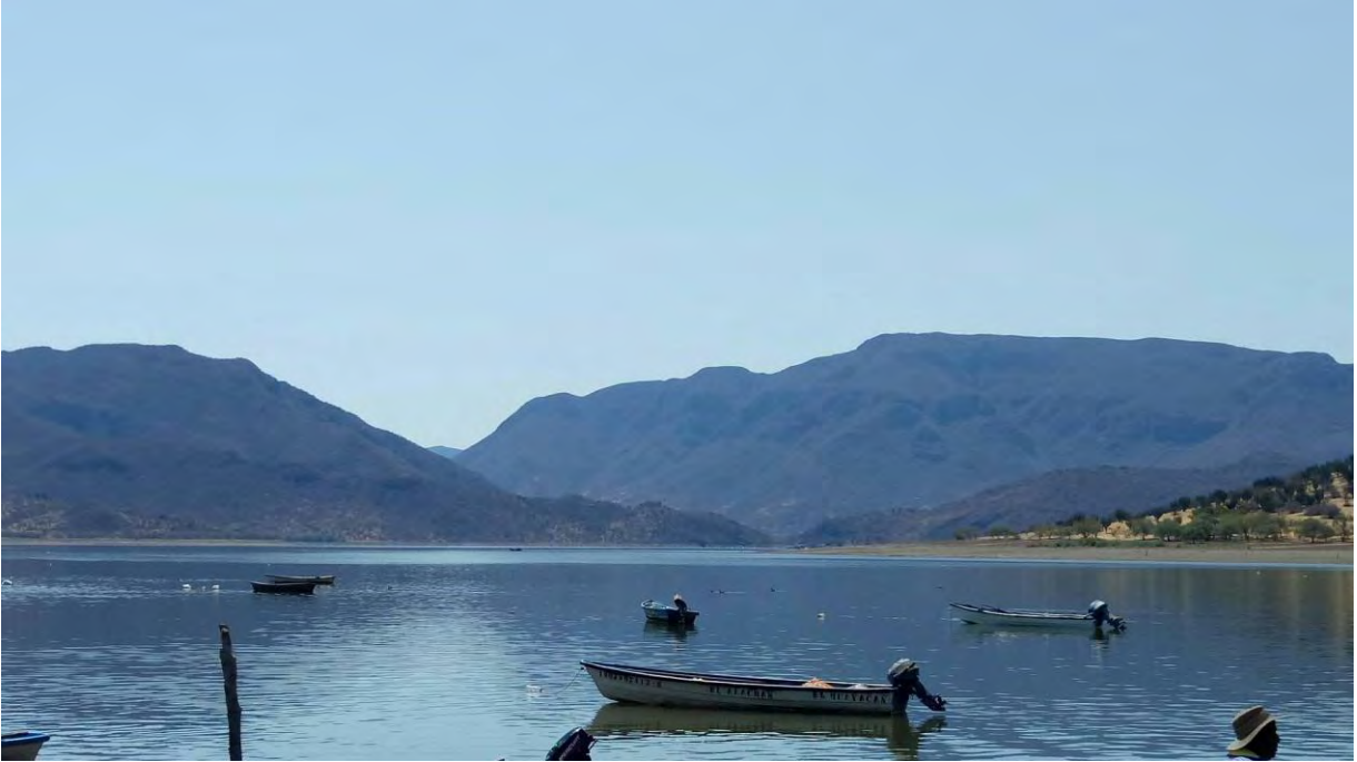
Figura 46. Presa El Infiernillo, Michoacán, México (Francisco, 2018).
