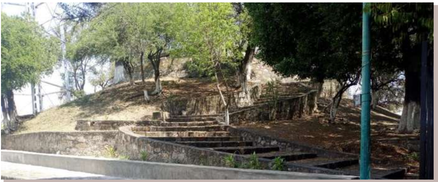
Fig. 14 Vista actual de “el cerrito”, antigua yácata pirinda, lugar de paseo en años posteriores y actualmente alberga en la parte superior el sistema de bombeo de agua potable.
