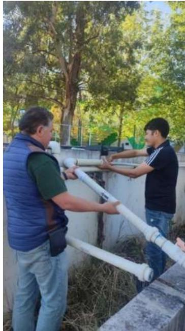
**Ilustración 18.** Refuerzo de la tubería que conecta al tanque de abastecimiento.
