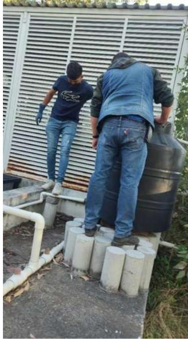
**Ilustración 20.** Lavado del tanque de abastecimiento.
