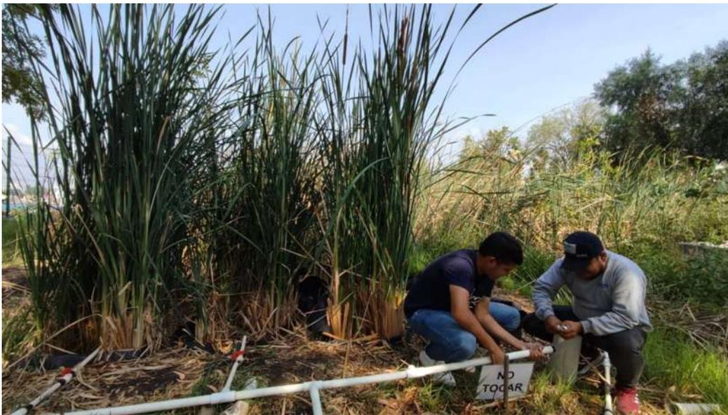
**Ilustración 22.** Mantenimiento de la red de tubería de los humedales artificiales experimentales.
