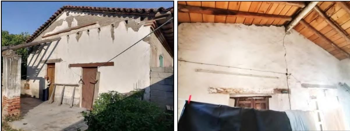
*Figura 3-4. Vivienda afectada por el sismo de Pijjiapan, de volumetría regular, con cubiertas de dos aguas, localizada en Santiago Laollaga. Fuente: fotografías del autor, 2022.*
