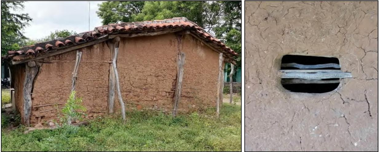
*Figura 3-11. Ejemplos de disposición de entramados. Fuente: fotografía del autor, 2022.*
