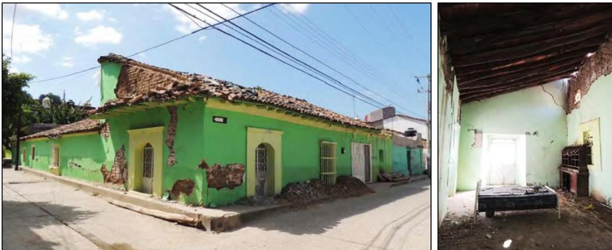
Figura 3-3. Vivienda afectada por el sismo de Pijijiapan, de volumetría irregular, con cubiertas a un agua, localizada en Tehuantepec. Fuente: FAHHO, 2020.<sup>24</sup>
