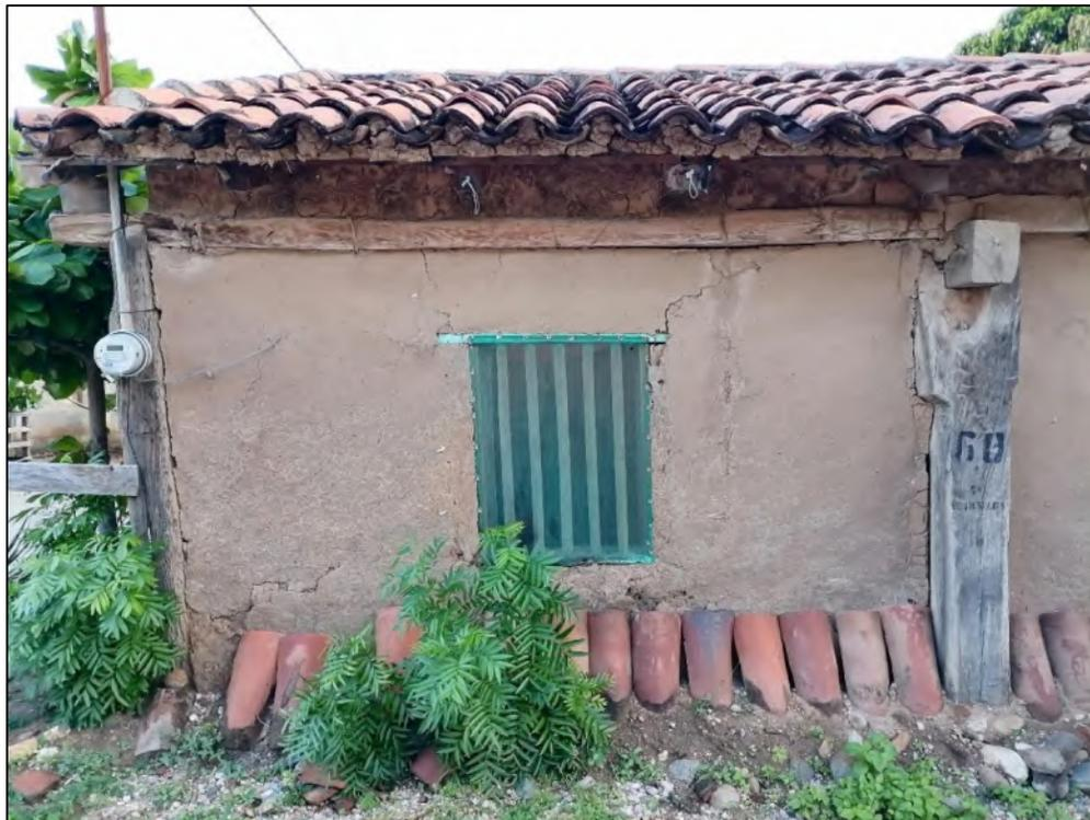
*Figura 3-6. Daños en muros en vivienda de bajareque. Se aprecian tanto agrietamientos diagonales desde las esquinas de las ventanas, como separación del muro con pilares. Fuente: fotografía del autor, 2022.*
