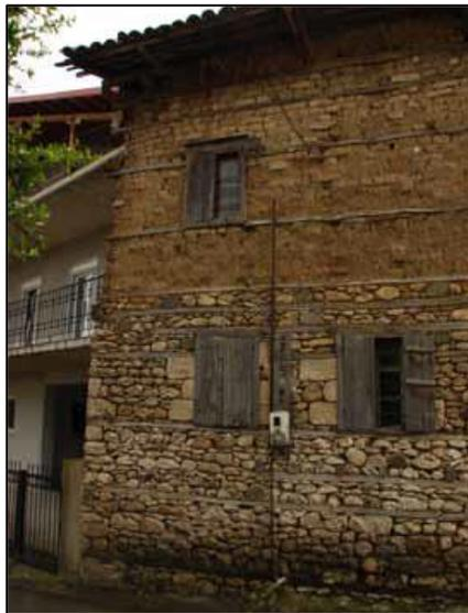
*Figura 3-16. Ejemplo emblemático de reforzamientos horizontales de madera en construcciones de mampostería en Grecia. Fuente: Jorquera, 2014.<sup>35</sup>*
