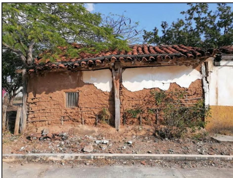
*Figura 3-7. Vivienda en desuso severamente deformada. Fuente: fotografía del autor, 2022.*
