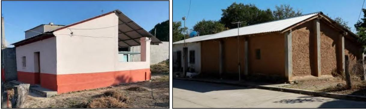
*Figura 3-15. Modificación autogestiva de cubiertas en las que se observa la sustitución de cubiertas de teja por lámina metálica. Fotografías del autor, 2022.*
