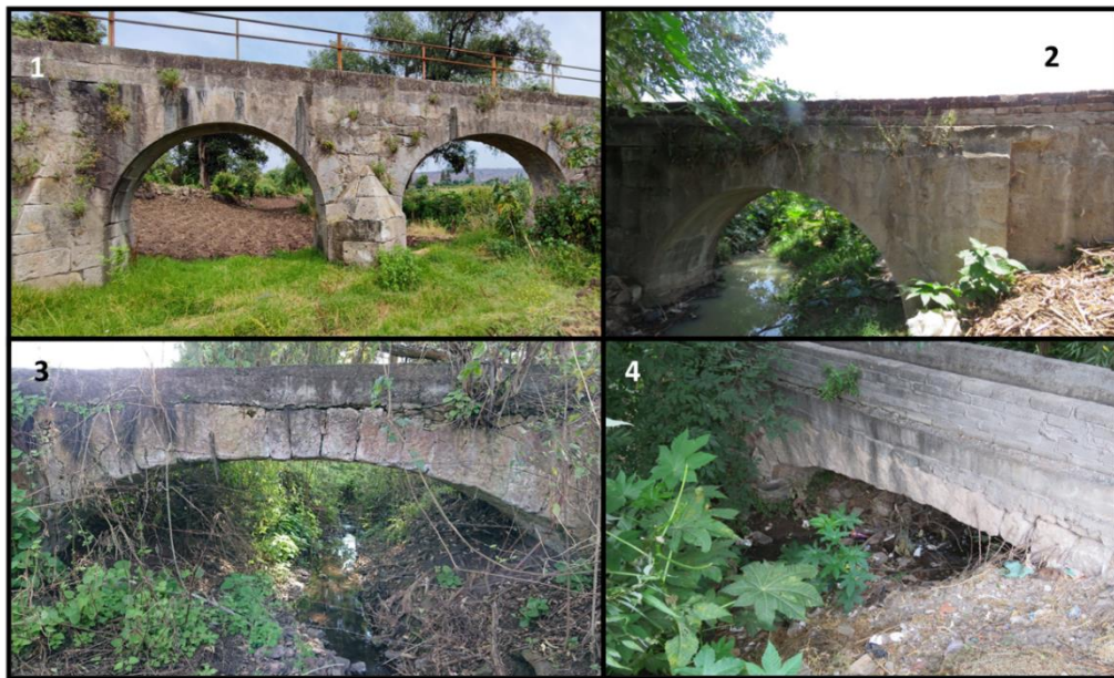
Imagen 25. Tipo 2: Canales de sillares de cantera. Foto 1. Canal en el casco de la hacienda. Foto 2. Canal del acueducto del casco. Foto 3. Canal ubicado en “El Nazareno”. Foto 4. Canal que se conecta al acueducto de “El Arquito”. Fotos: Dante B. Martínez.
