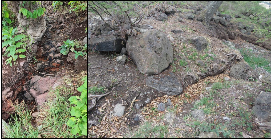
Imagen 29. Tipo 6: Canales de tierra. A la izquierda: Ejemplo de canal de tierra en la zona del casco de la hacienda. A la derecha: Ejemplo de canal hecho sobre tepetate en el predio como “El Sobrado”. Fotos: Dante B. Martínez.
