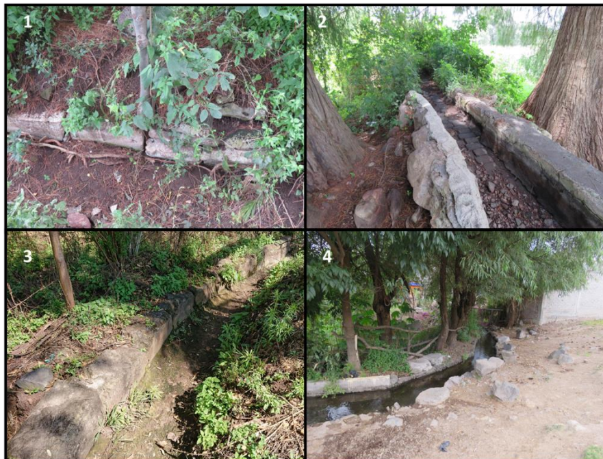
Imagen 25. Tipo 2: Canales de sillares de cantera. Foto 1. Canal en el casco de la hacienda. Foto 2. Canal del acueducto del casco. Foto 3. Canal ubicado en “El Nazareno”. Foto 4. Canal que se conecta al acueducto de “El Arquito”. Fotos: Dante B. Martínez.
