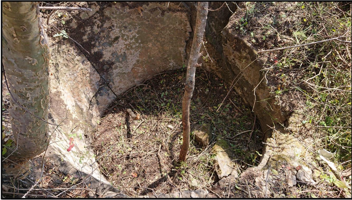
Imagen 80. Antiguo horno de cal ubicado en el predio conocido como “El Aguaje”. Mide 1.40 mts. de profundidad por 1.55 mts. de diámetro. Foto: Dante B. Martínez.
