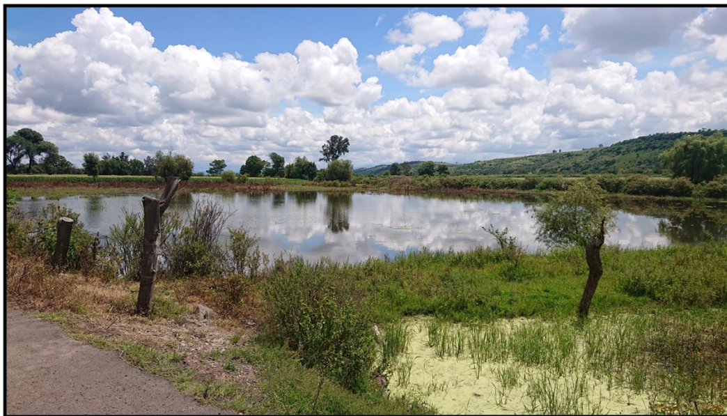
Imagen 59. Presa de Santa María, construida en 1883. Antigua laguna de Santa María. Foto: Dante B. Martínez.
