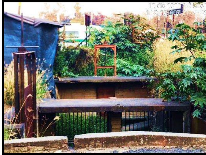
Figura 50.- Compuerta que forma parte de la estructura de regulación en la planicie de inundación.
