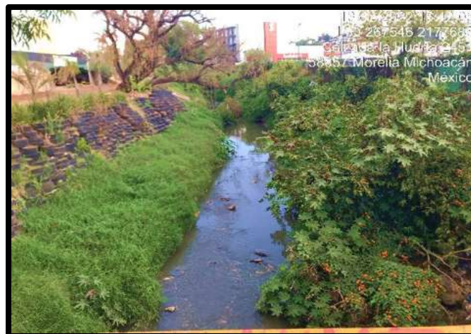
Figura 61.- Sección del cauce alterada con materiales no aptos
