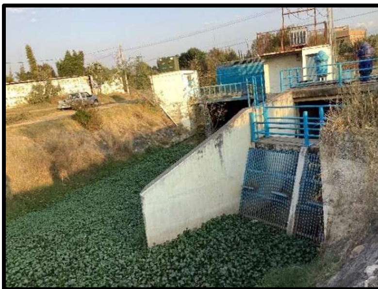
Figura 49.- Estructuras de control en la confluencia con el Río Grande.
