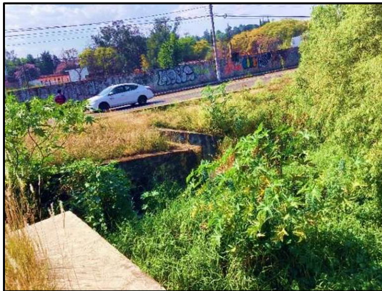
Figura 44.-Margen Izquierda desde el puente en calle Chiapas
