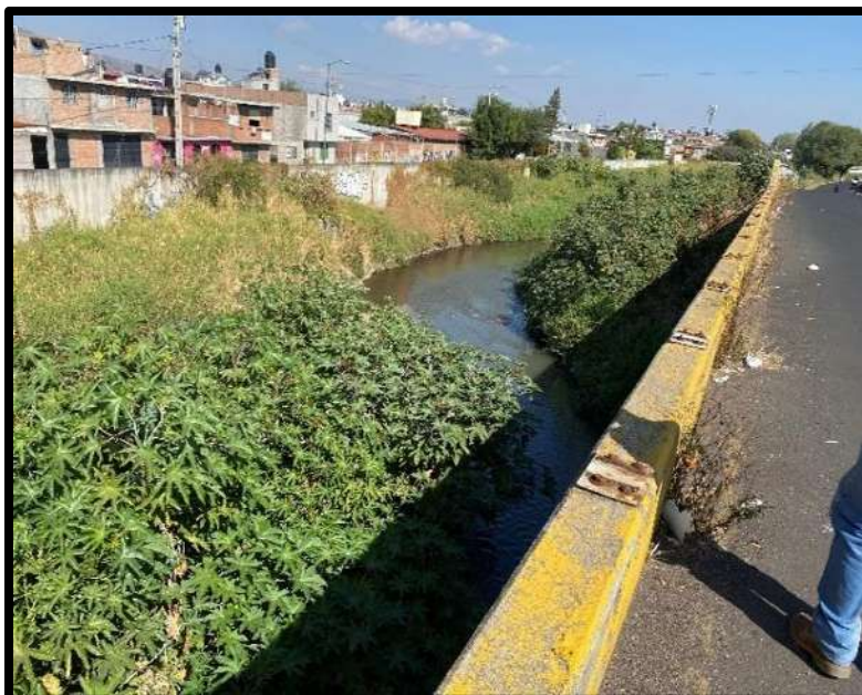
Figura 55.- Confluencia entre el Río Chiquito y el Río Grande sin estructuras de control
