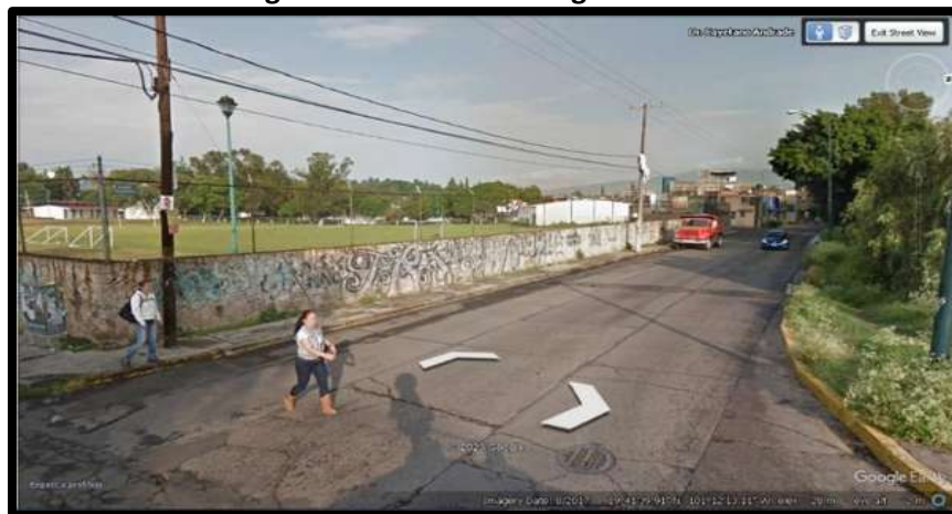
Figura 65.- Muro lindero correspondiente al internado España-México a la izquierda del margen izquierdo del Río Chiquito
