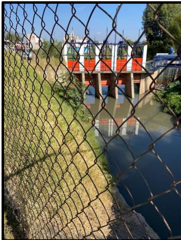
Figura 53.- Estructura de control en confluencia entre el dren Arroyo de Tierra y el Río Grande.
