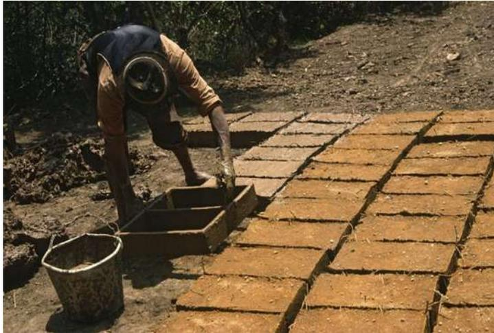
*Figura 4: Fabricación de bloques con adobe.*
