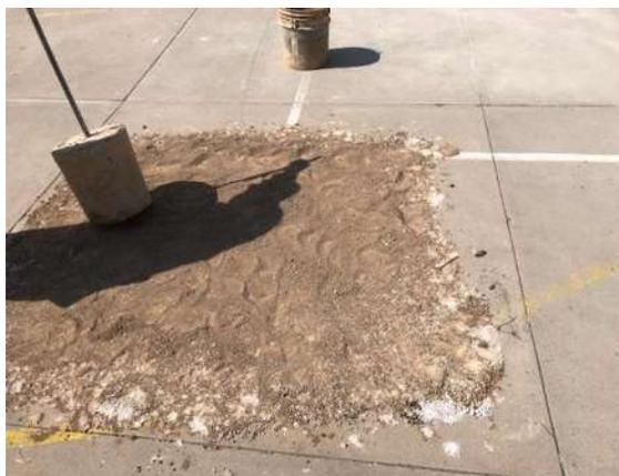
*Figura 16: Tendido de material*
