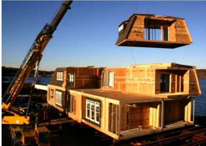
*Figura 14: Construcción modular*
