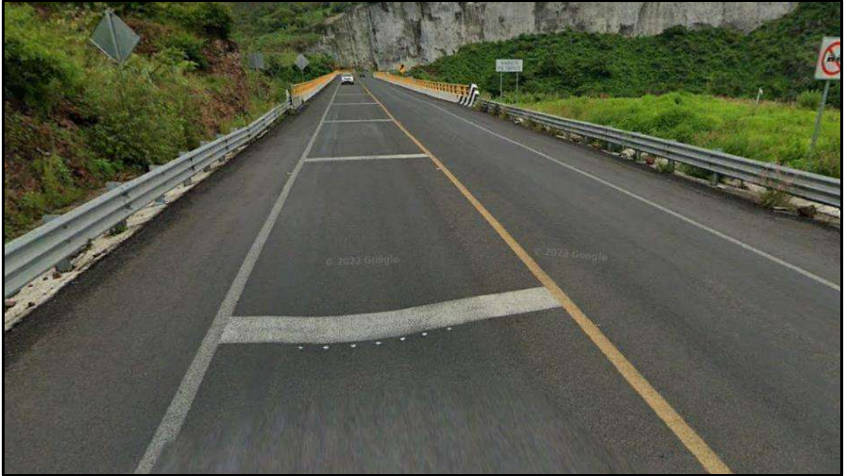
Ilustración 30. No se aprecian deterioros, km 102+230 (PEPSA, 2023).
