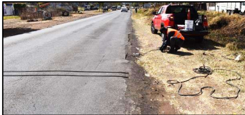
Ilustración 53. Colocación de bandas aforadoras de tránsito en estación 1: km 9+000 (PEPSA, 2023).
