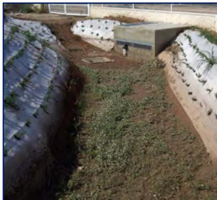
Zanjas de Infiltración
