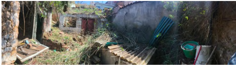
Ilustración 54. Inmueble interior con la primera limpieza realizada. Fotografía: K.X.F.C.
