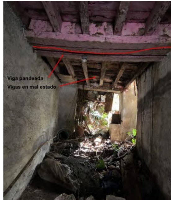
Ilustración 101. entrepiso del zaguán. Fotografía: KXFC. Elaborado por KXFC.
