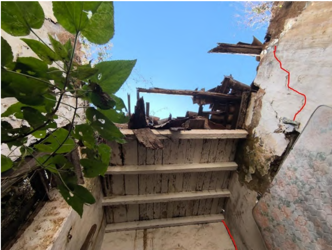
Ilustración 102. Cubierta y entrepiso de la sala. Fotografía: KXFC. Elaborado por KXFC.
