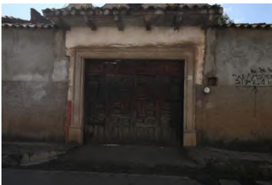
Ilustración 23. Aplanado de cemento con cerramiento de mampostería.
