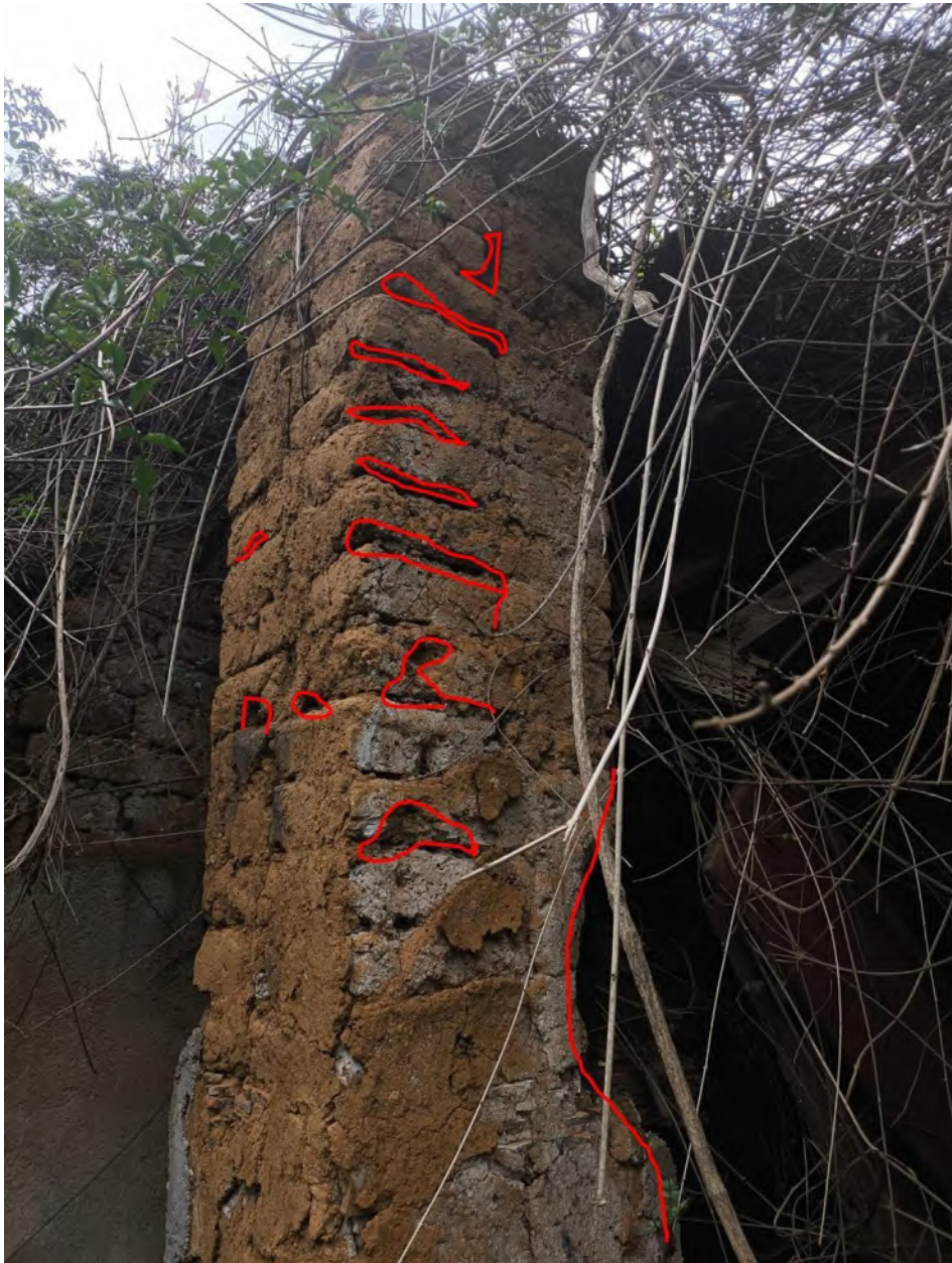
Ilustración 98 Columna de mampostería Fotografía: KXFC. Elaborado por KXFC.
