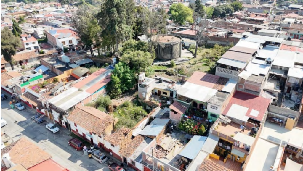
Ilustración 26. Vista aérea de la zona del pozo del oapás. Vuelo de dron: ADCC.
