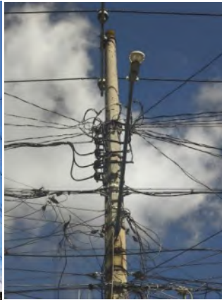
Ilustración 15. Luminaria vista completa. Fotografía: KXFC, mayo 2025.
