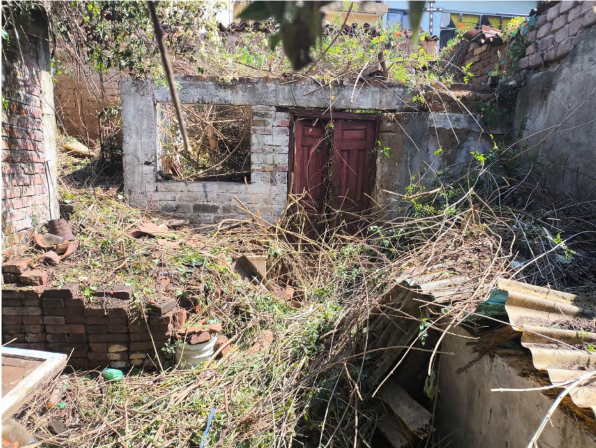
Ilustración 76. Bodega, cocina, fogón y pila. Fotografía: KXFC.
