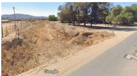
Figura 10 Vista de arroyo. Fuente Google maps. Consulta 2024
