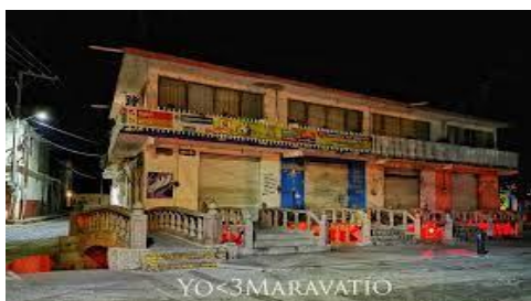
Alcantarilla de Maravatío 200
