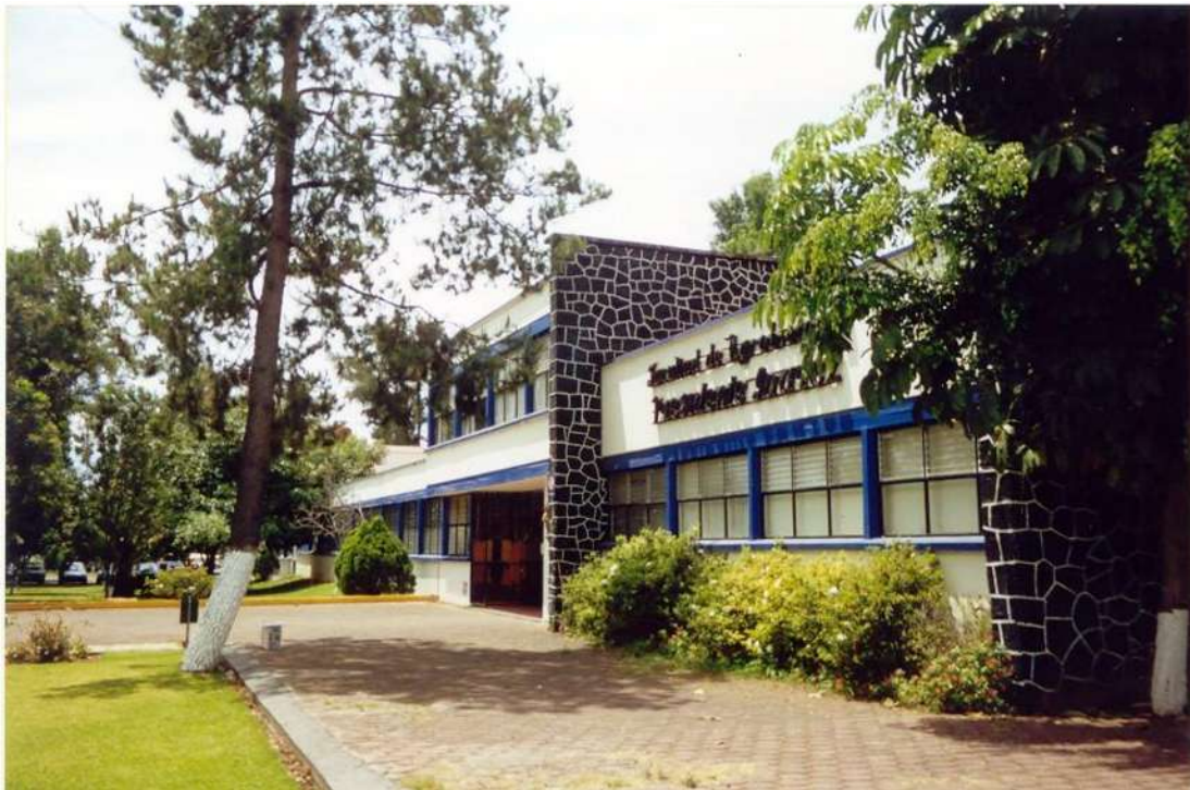
Figura 3. Fotografía del edificio principal de la Facultad de Agrobiología “Presidente Juárez”.
