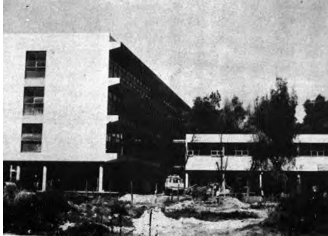
Fig. 45 Escuela Superior de Ingeniería y Arquitectura IPN, 1937.
