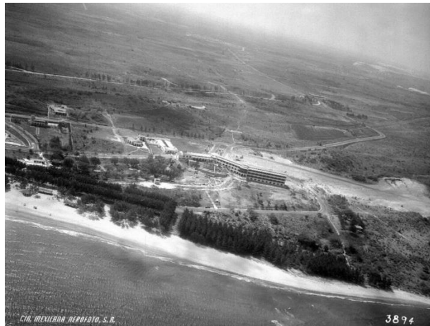
Fig. 145 Vista aérea del Hotel Mocambo.
