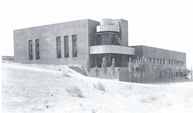
Fig. 77 Central Térmica de la Ciudad Universitaria de Madrid, Arq. Manuel Sánchez Arcas, 1932.
