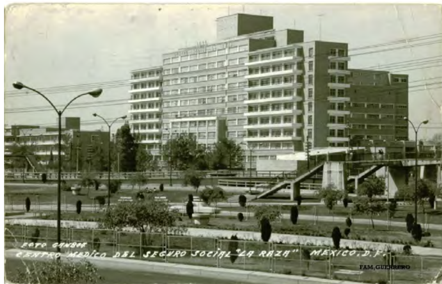
Fig. 150 Ejecución de obras en el Centro Medico Nacional "La Raza", México.
