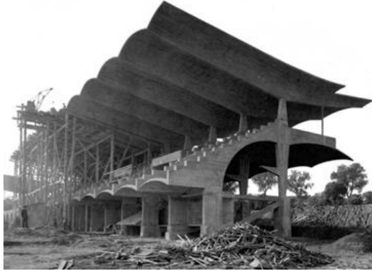
Fig. 76 Hipódromo de la Zarzuela, arquitectos Carlos Arniches y Martin Domínguez, ambos represaliados tras la guerra, proyecto estructural Ing. Eduardo Torroja, 1936.
