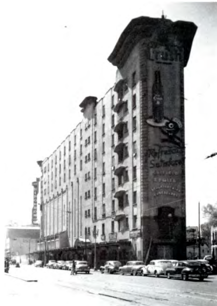
Fig. 55 Edificio ermita, Arq. Juan Segura, 1934.
