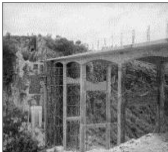
Fotografía 9. Puente en construcción
