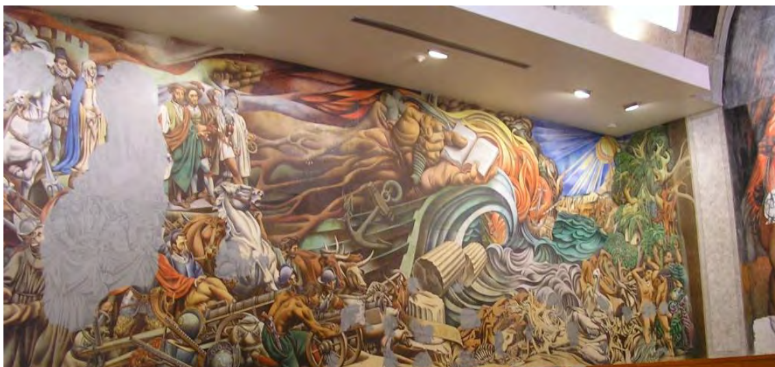
Imagen 24: Daños al mural España hacia América .
