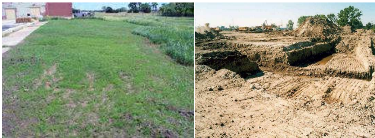
Figura 2- 19: La excavación de un sitio contaminado con metales, explosivos, compuestos volátiles y semi-volátiles; suelo antes (izq.) y después (der.) de la limpieza.
