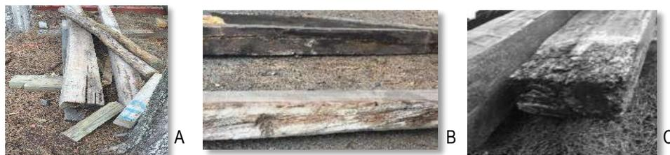
Figura 7. 2 Vigas actuales de madera de pino nacional, (A y B) Secciones de vigas, de madera de pino nacional.
