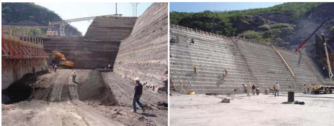
La presa Francisco J. Múgica en construcción, octubre del 2009
