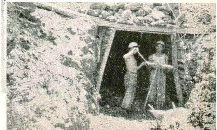
su extrema dureza y gran resistencia. Ambos fueron empleados como postes y cabezales en el ademe de los socavones de las primeras compañías, o sea, parados entre 1905, y 44 años después de hechos estos túneles, abandonados y sin mantenimiento alguno, muchos de ellos estaban firmes y resistentes.<sup>111</sup>
