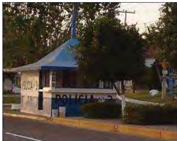
Ilustraciones 90 Caseta de vigilancia en el acceso a Villas Fotos: Jesús Cordero
