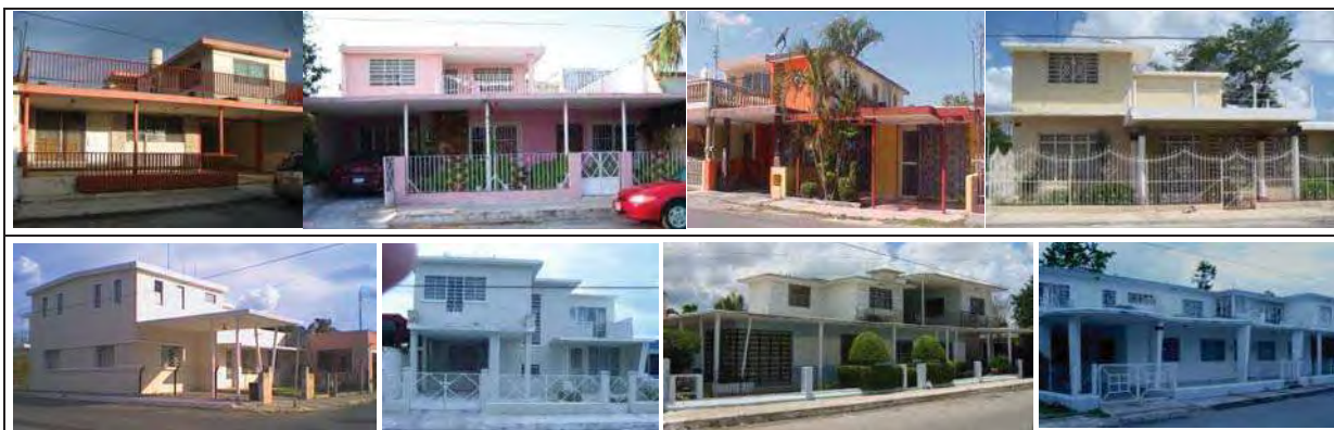
Figura 49. Transformación por agregados de construcción en planta alta. Fuente: Trabajo de campo, 2006.
