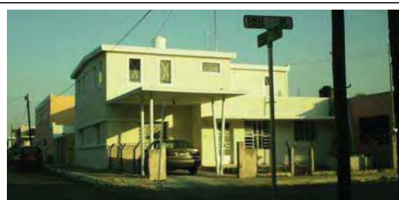
Figura 27. Agregados de construcción de en planta baja y planta alta, en la vivienda de la Colonia Miguel Alemán. Fuente: Trabajo de campo, 2006.
