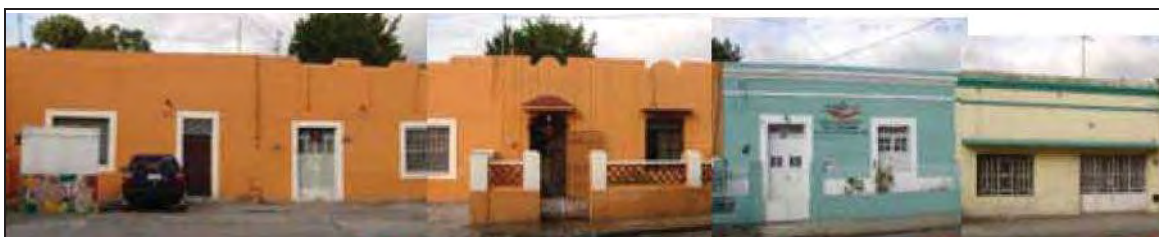
Figura 71. Viviendas ubicadas en la calle 69 entre 70 y 72.
