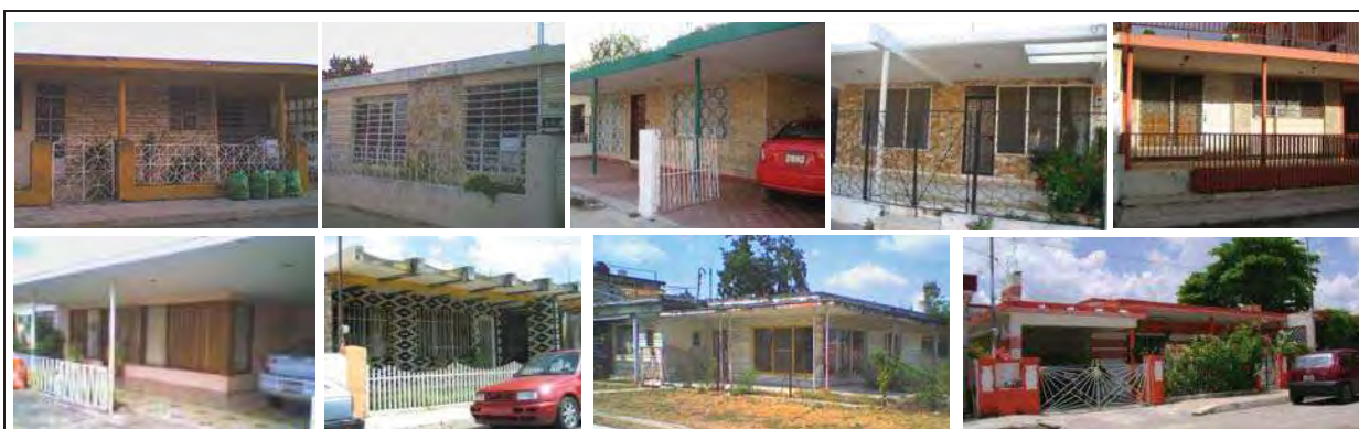
Figura 42. Transformaciones en la fachada de la vivienda original por agregados de texturas Fuente: Trabajo de campo, 2006.
