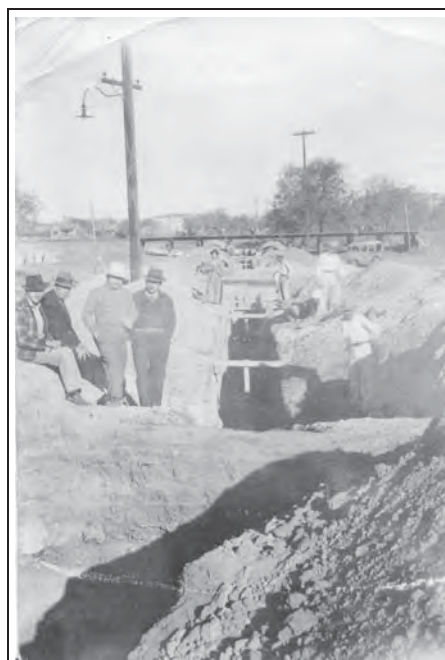
Figura 131. Excavación para la introducción del drenaje colectivo de la Colonia Miguel Alemán.
