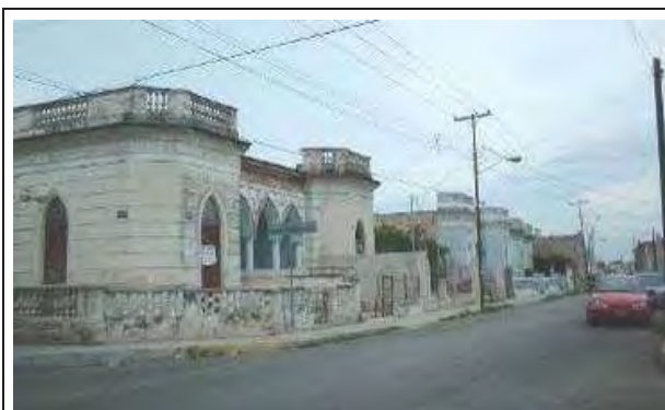
Figura 65. Vista de vivienda construida en modelo.
