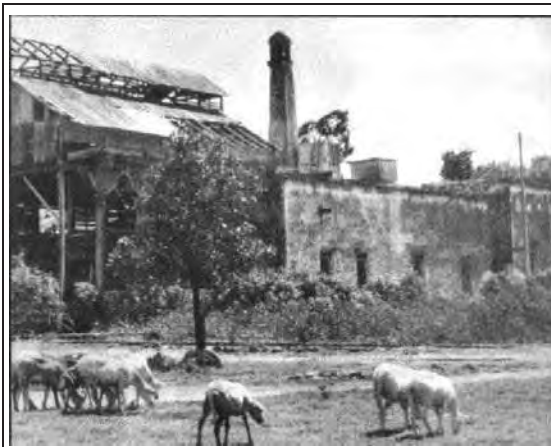
Figura 2. Vista del área de producción de una Hacienda henequenera.
