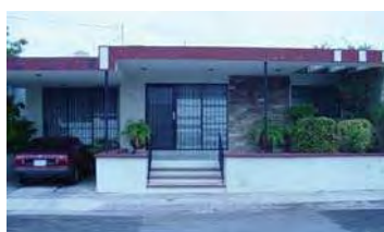
Figura 28. Vivienda con alta densidad constructiva. Fuente: Trabajo de campo, 2006, Vivienda de la Sra. María Teresa Vidiella.
