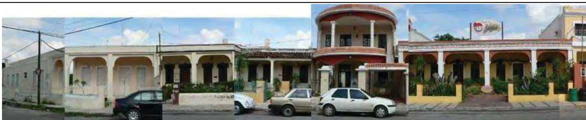
Figura 68. Caso de seis viviendas, ubicadas en la calle 21 entre 24 y 24.A, No. 117, con letras A, B, C, D, E y F.
