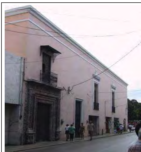
Figura 40. Portada de la casa de la calle 62 (59 y 61).
