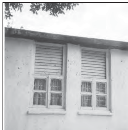
Figura 145. Detalle de ventanas de la vivienda de la Colonia Miguel Alemán.
