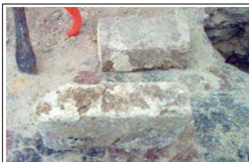
Figura 140. Detalle de block de cemento, de 7 x 14 x 28 cm, utilizado en la Colonia Miguel Alemán. Fuente: Trabajo de campo, 2006.
