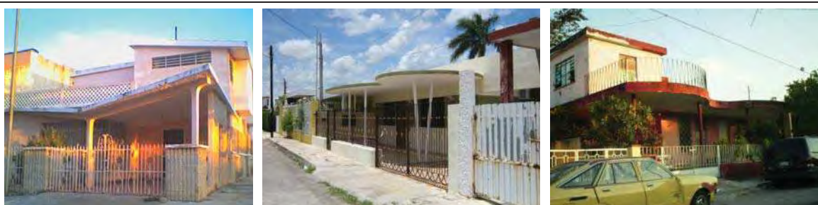
Figura. 45. Agregado de construcción en área frontal: terraza techada, jardín y cochera. Se observa dos formas “modernas”: inclinada y curva, en la losa de techo: Fuente: Trabajo de Campo 2005 y 2006.
