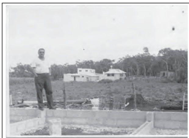
Figura 139. Construcción de cimentación con block, a cargo del Ing. Juan Riess Santner. Fuente: cortesía de Lupita Riess.
