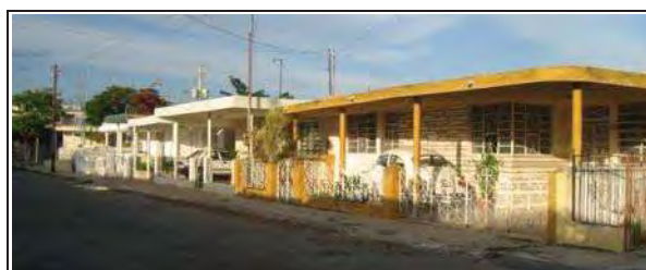
Figura 24. Construcción de terrazas delanteras en colindancia a lo largo de la cuadra.
