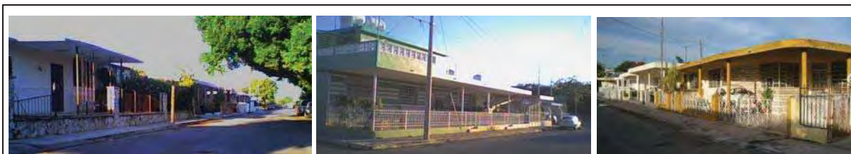
Figura 46. Transformación de la vivienda original por agregado de terrazas
