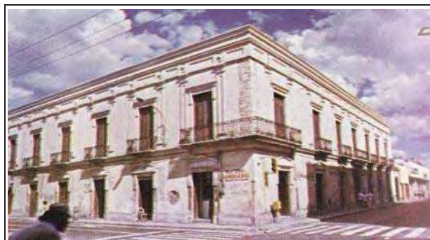
Figura 38. Casa ubicada en la calle 59 por 58 (Grupo 1).
