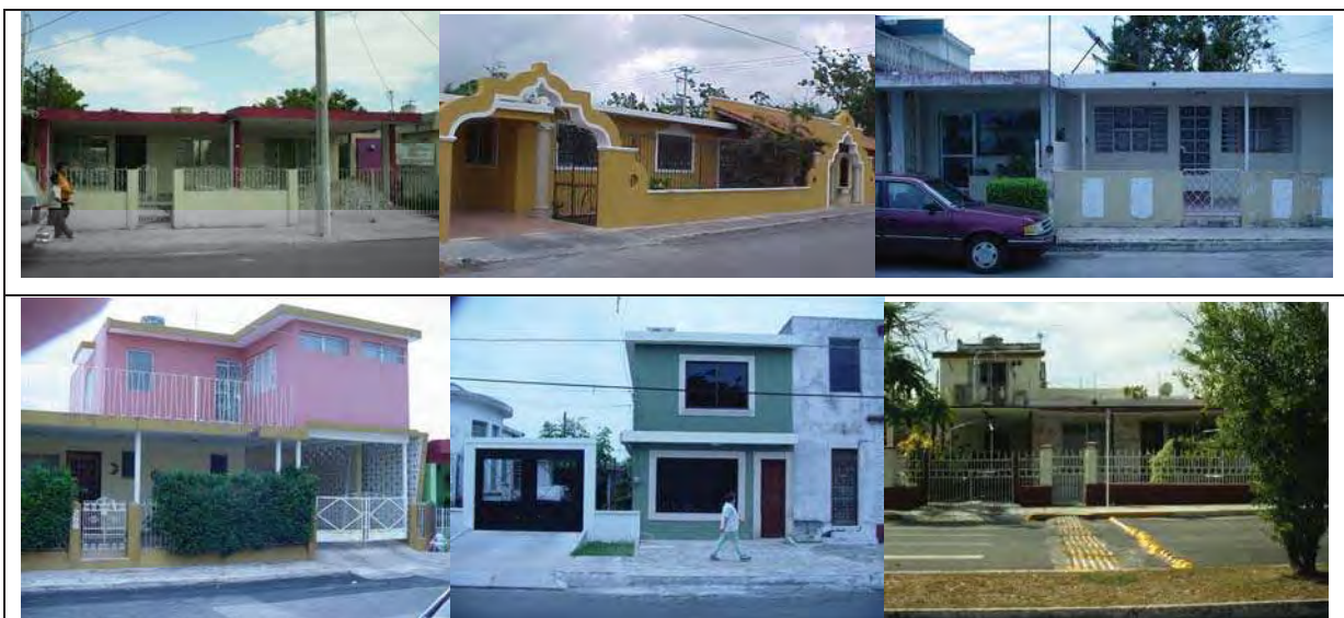
Figura 38. Vivienda con división predial y modificación de fachadas, Colonia Miguel Alemán. Fuente: Trabajo de campo en 2006
