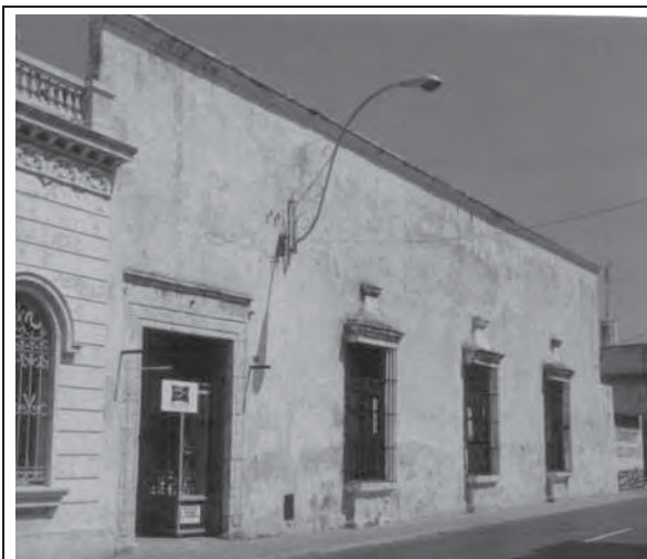
Figura 45. Fachada de la casa colonial de la calle 62 entre 55 y 57 (Grupo 2).
