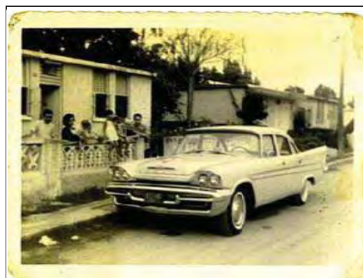
Figura 22. Construcción de terrazas y bardas en la vivienda de la Colonia Miguel Alemán.
