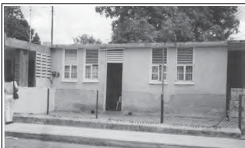
Figura 21. Vivienda original de la vivienda de la Colonia Miguel Alemán, con agregado de construcción.
