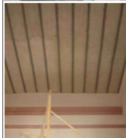
Figura 55. Techos de madera y de Viga decauville. Fuente: Trabajo de Campo, 1994 y 2006.
