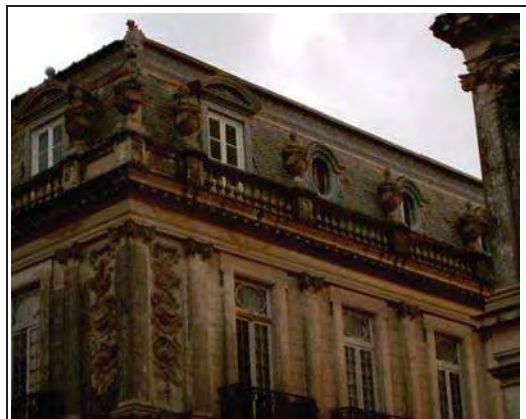
Figura 54. Detalle de las Casa Cámara, ubicadas sobre Paseo de Montejo (Grupo 1) Fuente: Trabajo de Campo, 2006.
