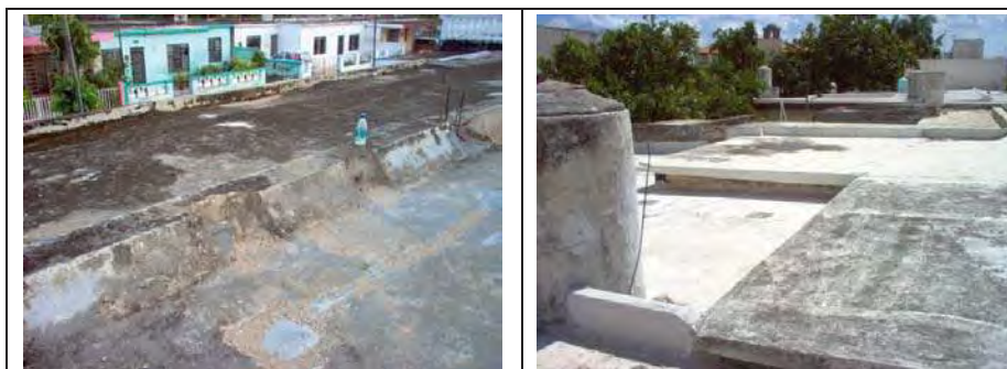
Figura 142. Detalle de trabe invertida y diferencia de nivel de techos en la vivienda de la Colonia Miguel Alemán.
